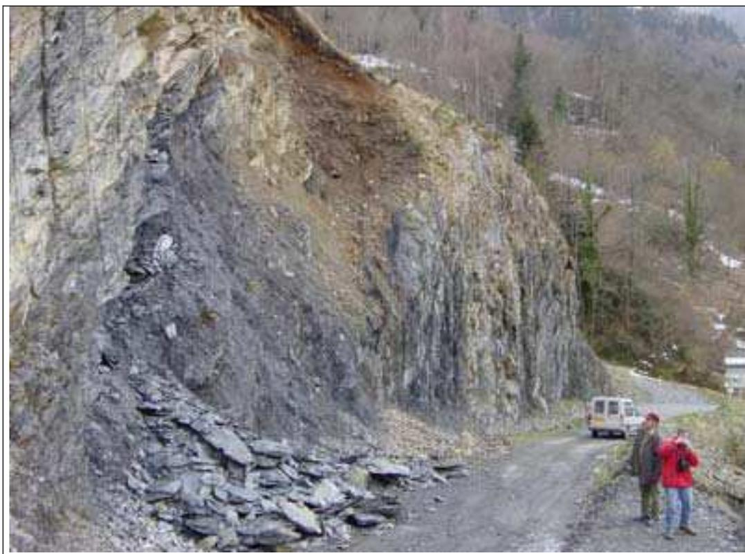
**Figure 18 : Exemple de chutes de blocs de schistes du Carbonifère au-dessus de la route nationale 134, sur le chemin de Gouetsoule (Mai 2004).**
