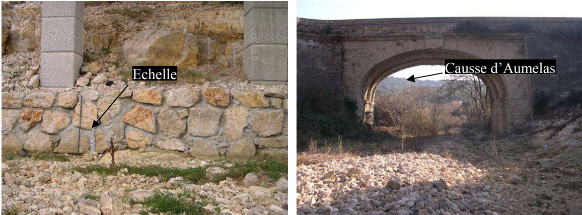
Fig. 19: La station amont : échelle limnimétrique et vue du Causse d'Aumelas en direction de l'aval
