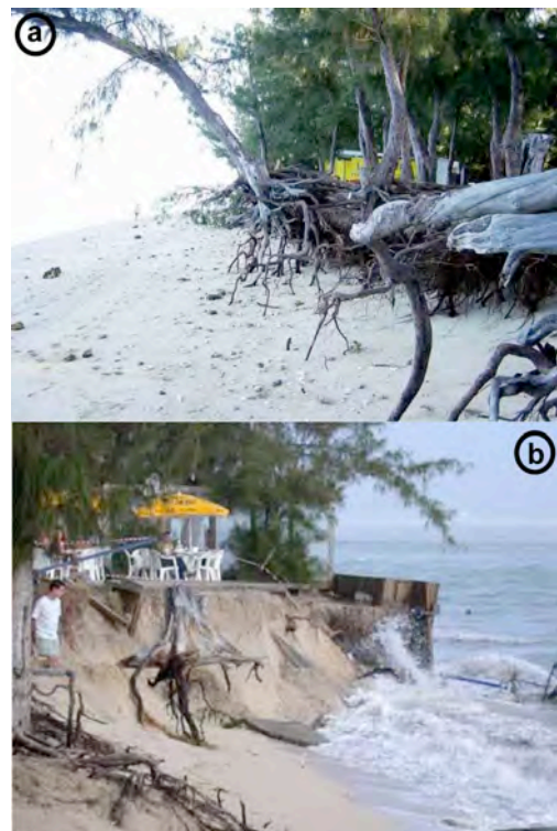
Figure 0-1 : Erosion d'une plage corallienne à La Réunion. a) le déchaussement des racines de filaos caractérise bien la présence du risque érosif, et b) perte d'un volume considérable de sable et destruction de la terrasse d'un restaurant suite à un épisode de forte houle australe en août 2003.
