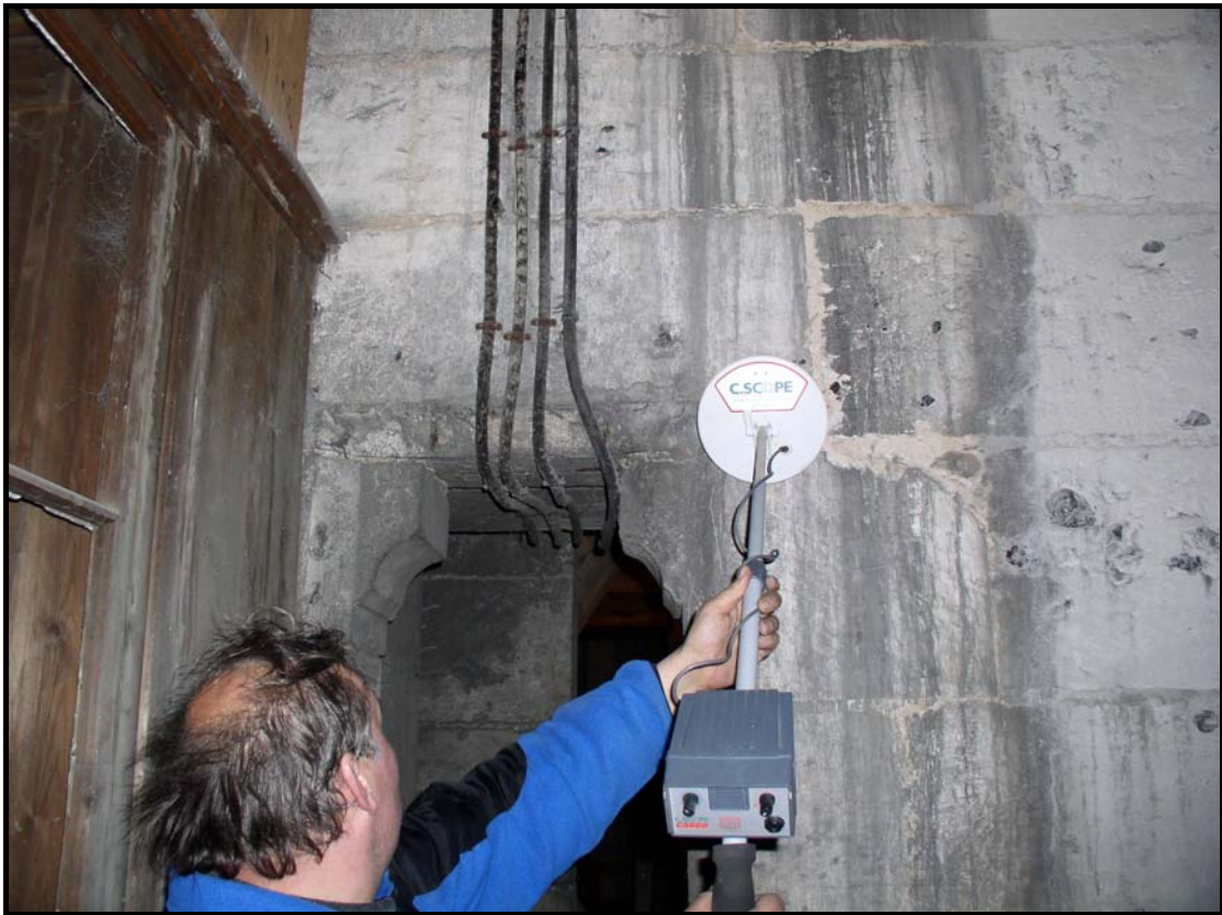
Figure 101 : Mise en évidence de la longueur d'ancrage des barres en linteau dans la maçonnerie par l'intermédiaire d'un détecteur de métaux, croisée du transept de l'église Saint-Ouen.
