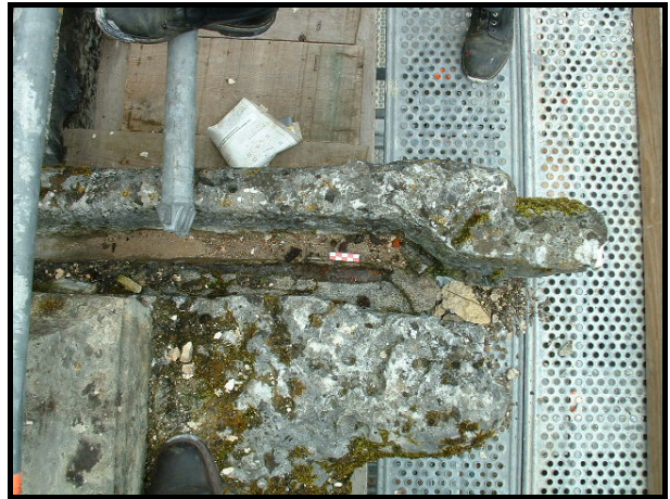
Figure 141 : A gauche, agrafes de restauration dans des gargouilles au 2e étage de la tour de la croisée. A droite, goujon dans une gargouille du chéneau du transept nord.
