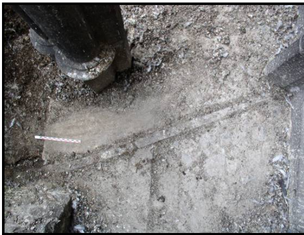
Figure 195 : Barres de fer dans le portail nord de la cathédrale de Troyes à hauteur de la claire-voie du triforium. En haut à gauche, barres de l'arcature du XIII e siècle et au fond, barre tenant le contrefort est en pierre de tonnerre (XV e siècle). En haut à droite, barres de l'arcature du XIII e siècle et barres retenant la pointe du gâble en pierre de tonnerre (XV e siècle). En bas, plan du portail nord à hauteur des chapiteaux des colonnettes de l'arcature avec les différentes barres (les tirants au sol n'ont pas été représentés pour plus de clarté).
