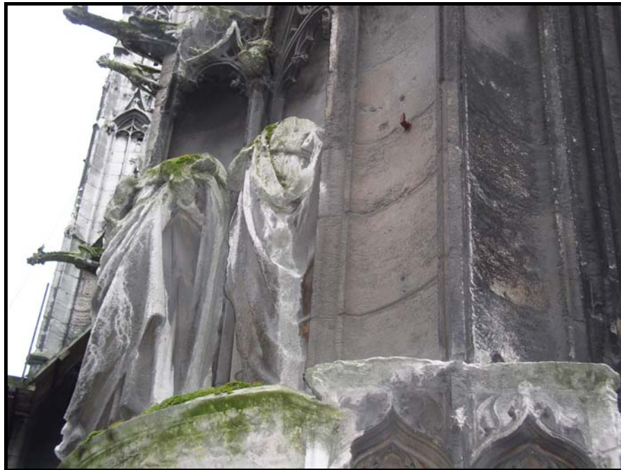
Figure 154: Crochets d'attaches de statues sur la façade.
