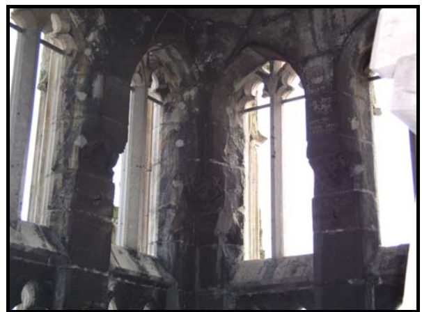
Figure 57 : Façade occidentale de la cathédrale de Rouen. En haut, vue générale et vue du haut de la tour Saint-Romain avec tirants dans les baies. En bas à gauche, anciens renforcements en fer des fleurons du campanile A de la façade, cliché G. Lanfry. En bas à droite, tirants dans les baies de la tour de Beurre.
