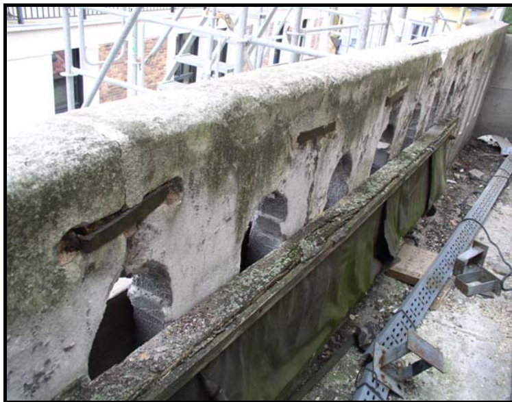
Figure 228 : Agrafes des balustrades du comble bas du chœur de l'église Saint-Jean, côté sud. En haut à gauche, agrafe H3 ; en haut à droite, agrafes H4 et V1 ; en bas à gauche, agrafes de la première travée : H6 et V2 à V6 ; en bas à droite, exemple de patte d'agrafe fendue.
