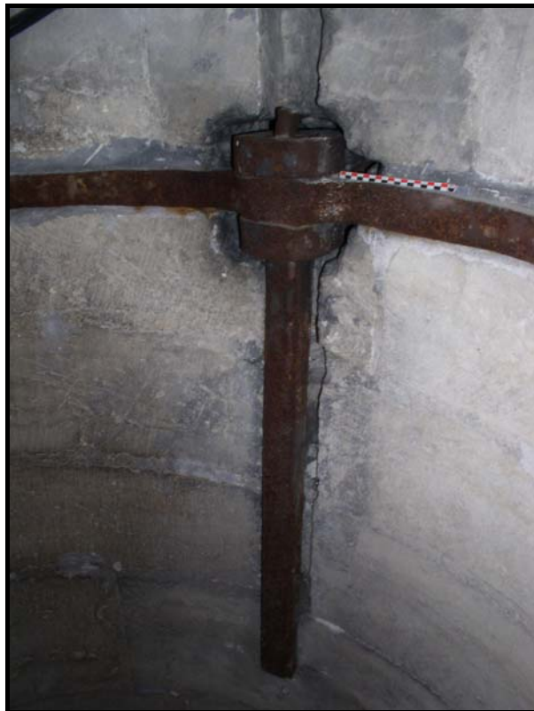
Figure 165 : Cerclage et chaînage au plafond du triforium du transept nord de la cathédrale de Troyes. En haut à gauche, localisation. En haut à droite, partie du chaînage avec vue de l'assemblage entre deux chaînons côté ouest. En dessous, partie terminale du chaînage dans la pile nord-est de la croisée. En bas à gauche, assemblage entre le cerclage et le chaînage dans l'escalier du contrefort nord-est. En bas à droite, assemblage du cerclage.
