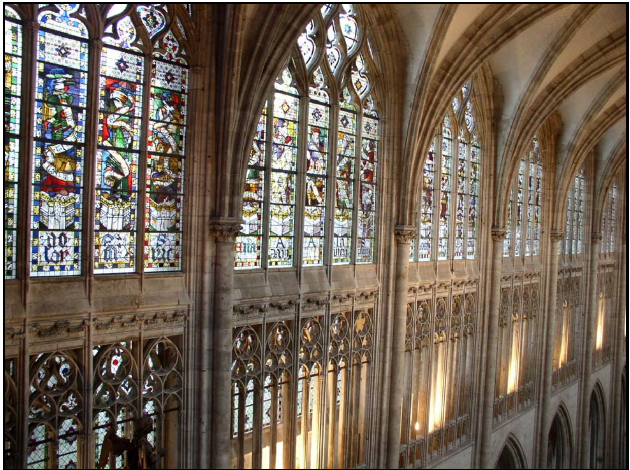
Figure 78 : A gauche, vitraux des fenêtres hautes du transept de l'église Saint-Ouen et leurs armatures de fer. A droite, vitrail des fenêtres hautes du chœur avec la présence de barlotières-tirants. En bas, vue des baies hautes de la nef et de leurs tirants.
