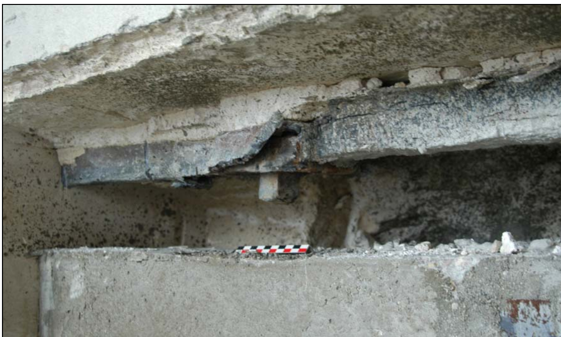
Figure 273 : Chaînage périphérique au 4 e étage du donjon du château de Vincennes.
