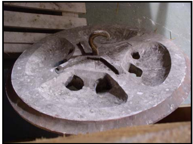
Figure 191 : Deux systèmes d'attache de boutons de clefs de voûte dans la nef de la cathédrale de Troyes.
