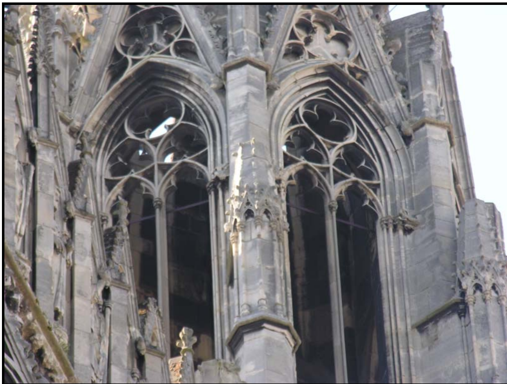
Figure 129 : Tirants de l'arcature des tours du massif occidental de l'église Saint-Ouen, cliché P. Benoit.
