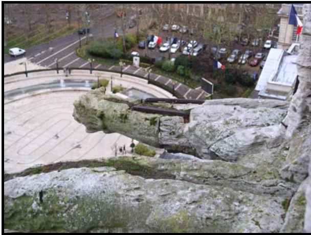
Figure 141 : A gauche, agrafes de restauration dans des gargouilles au 2e étage de la tour de la croisée. A droite, goujon dans une gargouille du chéneau du transept nord.
