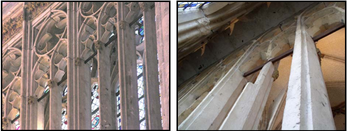
Figure 84 : Tirant en partie haute du triforium du chœur, clichés P. Benoit et M. L'Héritier.
