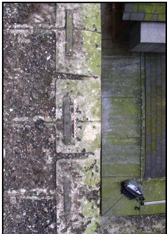
Figure 189 : Agrafes sur la coursiue des fenêtres hautes de la cathédrale de Troyes. En haut, extrémité d'une agrafe qui passe sous le socle d'un pilier ; en bas à gauche, transept nord-ouest travée nord ; en bas à droite, transept nord-est travée centrale.
