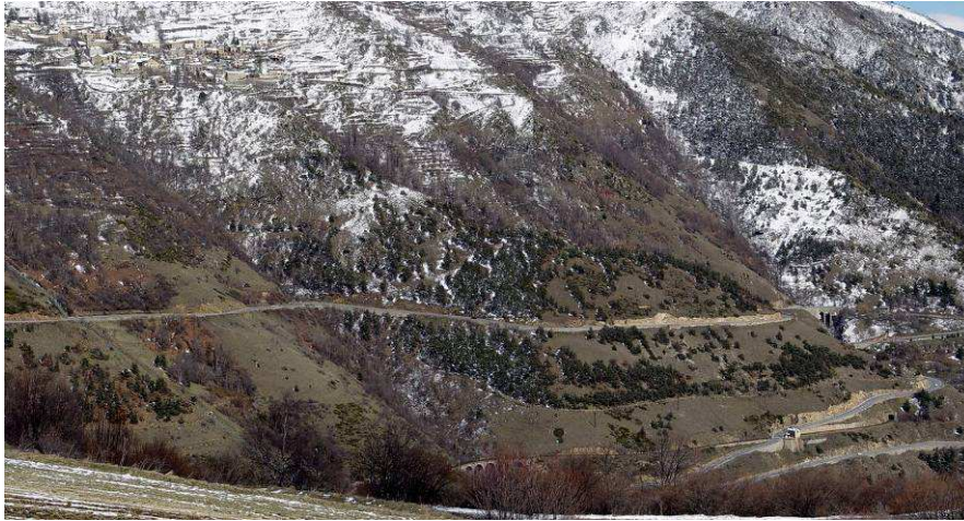
Figure 1.23 Vue panoramique du secteur du Pallat (aperçu de l'ensemble des ouvrages à protéger, notamment d'une voie ferrée en bas de la photo) [49].
