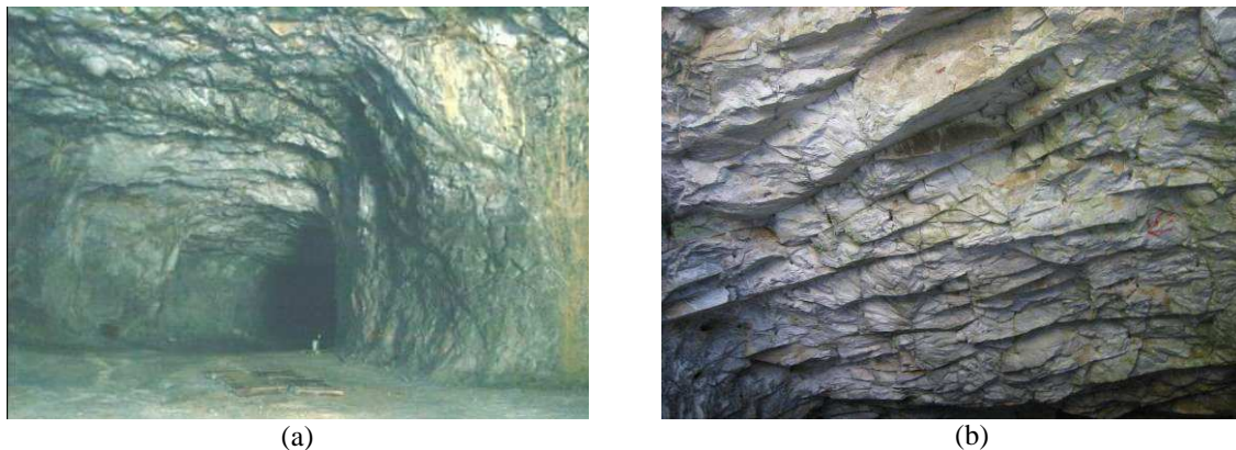
Figure 5-1 Saint-Béat , galerie du château : (a) parements verticaux (environ 10m de hauteur), (b) toit, stable sans renfort [1].
