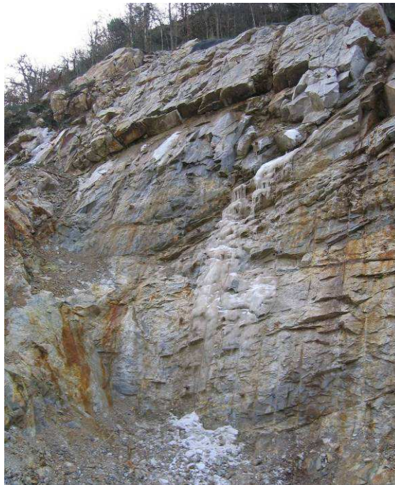
Figure 4.18 Photo de l'aménagement effectué dans le cadre du projet de la déviation d'Ax-les-Thermes.
