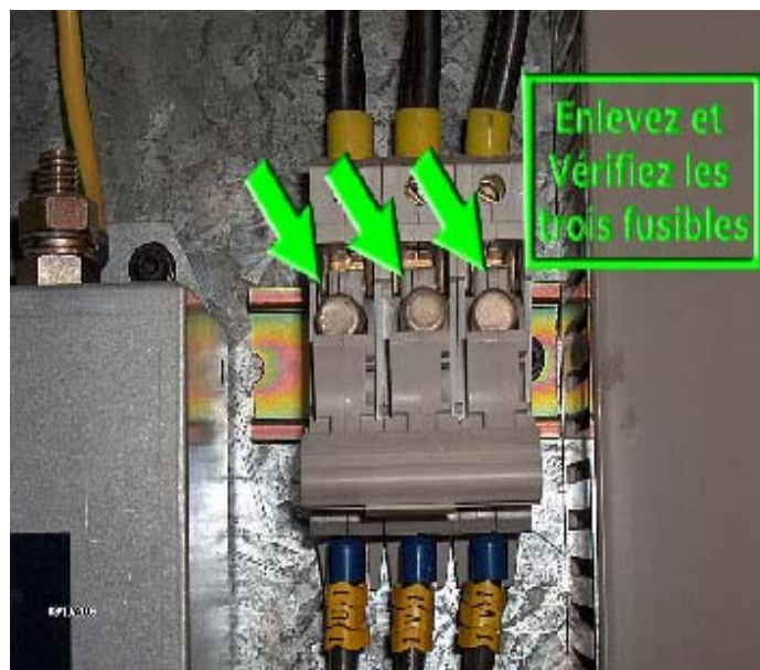
Figure 4. 16. Augmentation indiquant au Technicien les trois fusibles.
