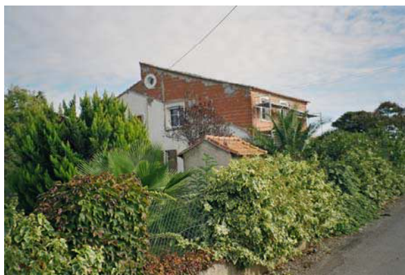
Photographie 4.1 : Rehaussement d'une habitation inondée à Cuxac-d'Aude (11) en 1999
