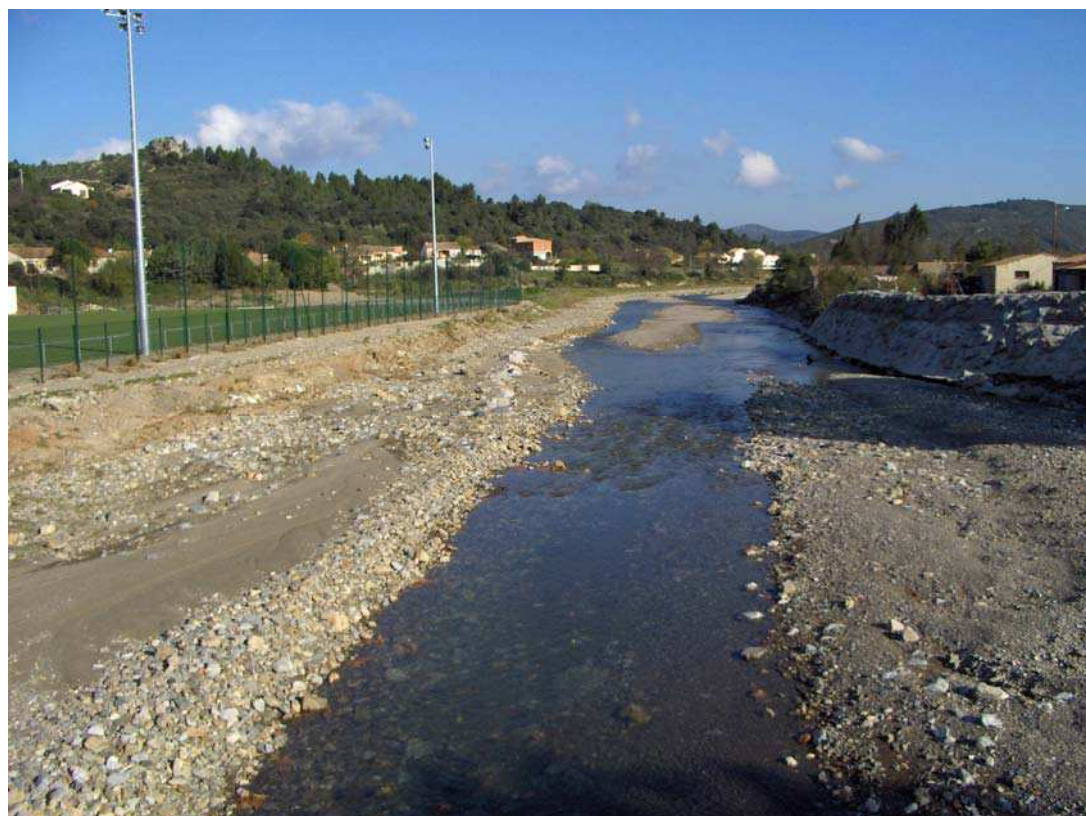
Photographie 4.8 : Le cours de la Berre au même endroit après les crues de novembre 2005 et janvier 2006. Le terrain de sport a été aménagé en rive gauche mais le recalibrage a disparu. On reconnaît l'enrochement à droite (cliché : F. Vinet, nov. 2006)
