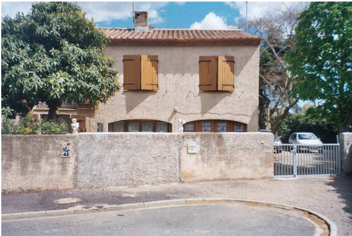
Photographie 2.3 : L'aménagement des rez-de-chaussée inondables en logement : un facteur d'augmentation du risque (exemple à Villeneuve-lès-Béziers, 34)
