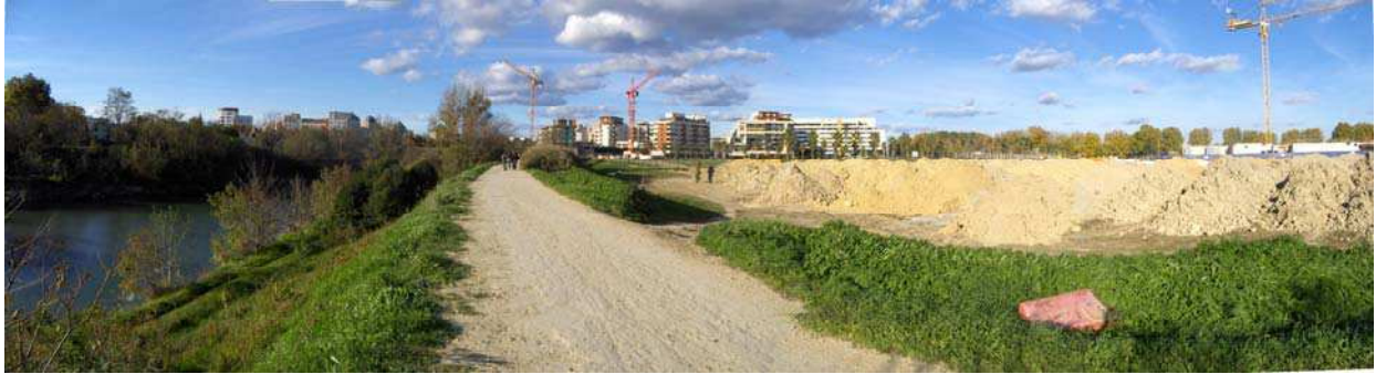
Photographie 3.4 : Le remblaiement du lit majeur du Lez à Montpellier.
