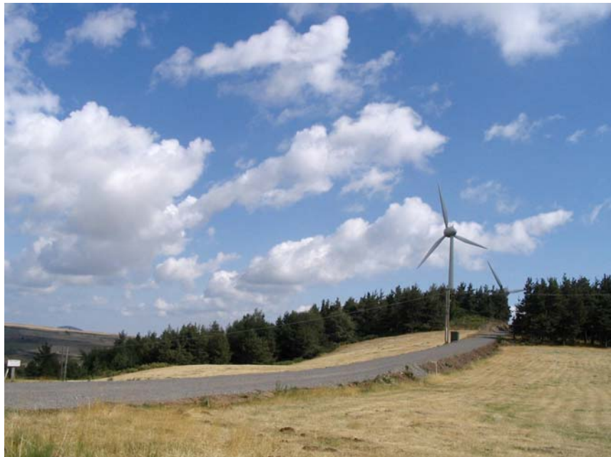
Figure n°51. Eoliennes sur le territoire de Saint Clément (Ardèche). Les pales dépassent la végétation environnante. (Cliché D. G.-F., Août 2005)
