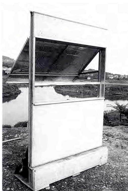
Photos 9 et 10 (annexe 16). Panneau de façade de l'immeuble d'habitation, square Mozart à Paris – 1953,1954. A droite, prototype de l'élément de façade.
