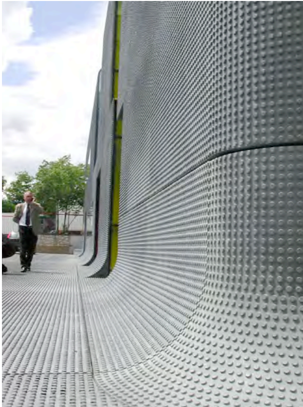
Photo N°7 : Bureaux pour la RATP à Thiais (banlieue parisienne). Détail de l'enveloppe en pied de mur : continuité entre sol et façade. Emmanuel Combarel et Dominique Marrec, architectes. [photo N. Hoyet]
