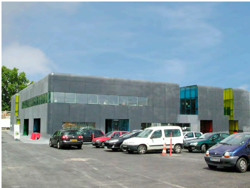
Photo N°6 : Bureaux pour la RATP à Thiais ( banlieue parisienne). Emmanuel Combarel et Dominique Marrec, architectes. [photo N. Hoyet]
