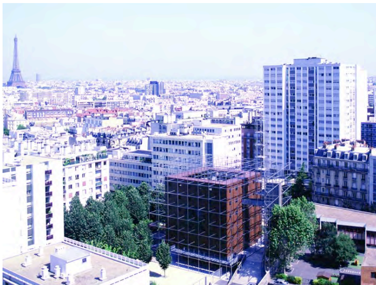
Vue de l'église Notre Dame de l'Arche de l'Alliance. « Le concept était un cube en bois » ARCHITECTE : ARCHITECTURE-STUDIO PHOTO : GASTON"
