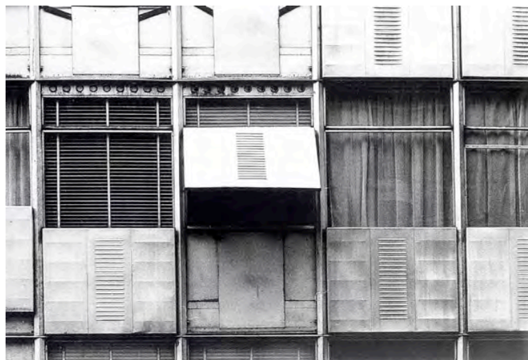
Photo N°27 : Immeuble d'habitation square Mozart à Paris. Façade fabriquée par les Ateliers Jean Prouvé (1953,1954). « Les panneaux de façade complexes préfabriqués à l'usine constituent à la fois l'allège, la fenêtre à guillotine, (équilibre caché), l'imposte, l'aérateur et le volet » (in Sulzer, 2005)
