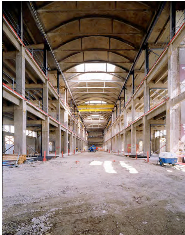
Rénovation de la Halle aux farines.
