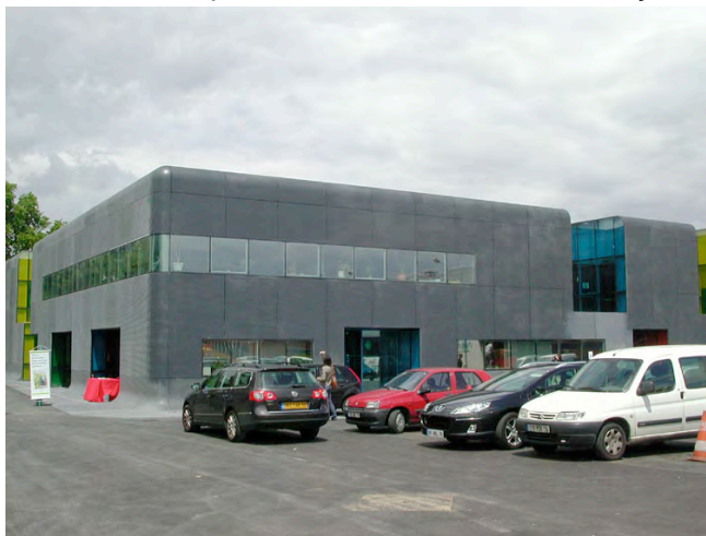
Dépôt pour la RATP à Thiais. Continuité entre sol du parking et façade Combarel et Marrec, architectes. (Photo N.Hoyet - mars 2007)
