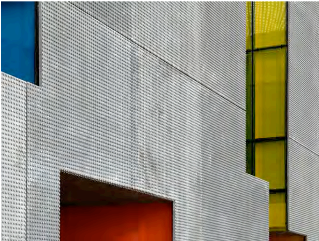
Façade du dépôt RATP à Thiais. Combarel et Marrec, architectes. Photo N.Hoyet
