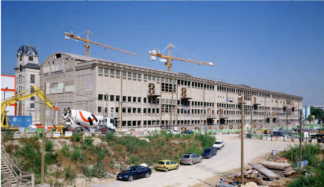
Rénovation de la Halle aux farines.
