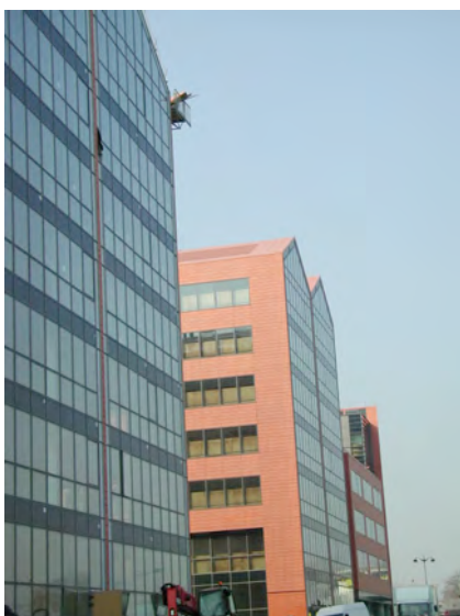
Cité du Millénaire à Aubervilliers. Arte Charpentier, architectes. Un bardage aux dimensions coordonnées avec les menuiseries. (Chantier Terreal ; photo N. Hoyet)
