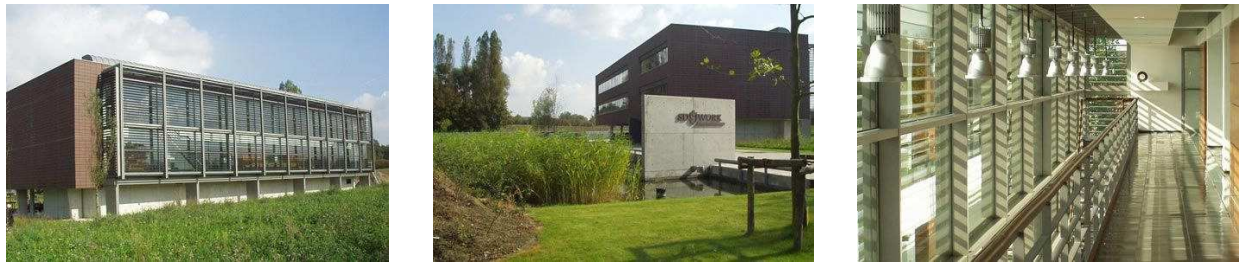
Figure 1.4 : Vues de l'immeuble de bureaux SD Worx (Breesch et al, 2005)
