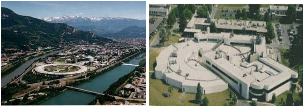
Figure 2.5 – Photos aériennes de deux synchrotrons où des expériences ont été réalisées au cours de ce travail. A gauche : ESRF – « Electron Synchrotron Radiation Facility » à Grenoble en France (anneau de stockage de 844m de circonférence, électrons accélérés à 6 GeV). A droite : NSLS – « National Synchrotron Light Source » au BNL – « Brookhaven National Laboratory » à New York aux Etats-Unis (anneau de stockage de 170m de circonférence, électrons accélérés à 2.8 GeV);
