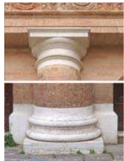
Figure 68. Ambiguïtés entre le vocabulaire de l'architecte et les divisions physiques des éléments réalisés.
