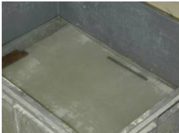
(d) mise en place des poids métalliques
