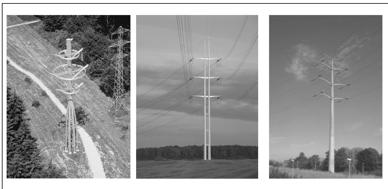
Photographies 4, 5 et 6 : Pylônes « Corolle » (en bois), « Roseau », et « Muguet » 41
