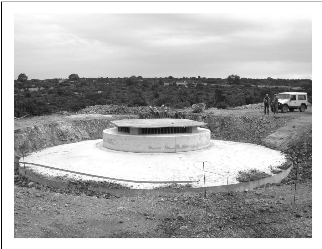
Photographie 39 : Chantier du parc éolien de Villesèque-des-Corbières (fondations d'une éolienne) 419
