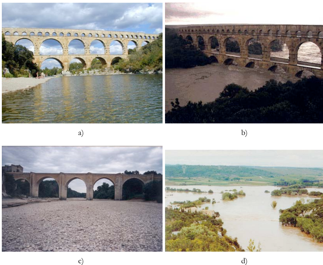
FIGURE 4.2 – Cliché des sites où les plus hauts niveaux de crue ont été mesurés pour la crue des 8 et 9 septembre 2002 dans le Gard. Clichés a et b : Le Gardon au niveau du Pont du Gard, hors crue à gauche, en crue à droite. Clichés c et d : Le Gardon au niveau du Pont de Saint-Nicolas de Campagnac, hors crue à gauche, au plus fort de la crue à droite.
