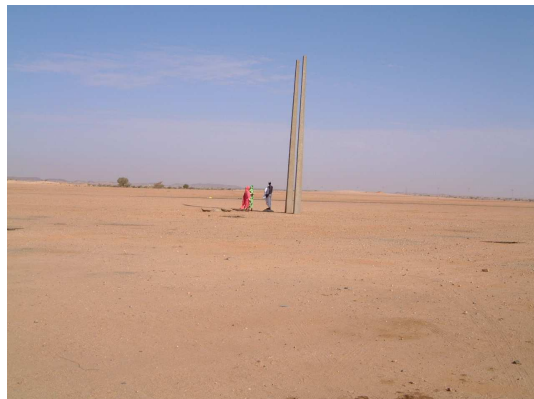
Les câbles électriques sont attendus dans ce quartier périphérique de Thawra, 2002.
