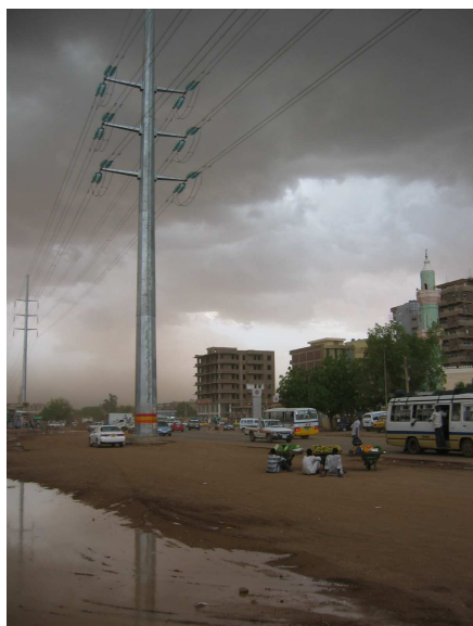
Câbles haute tension du centre-ville, 2005.
