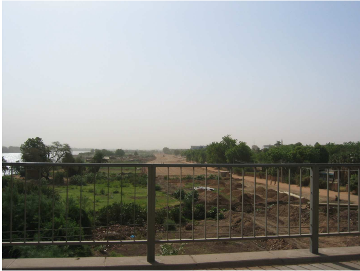
Construction d'une route le long du Nil bleu
