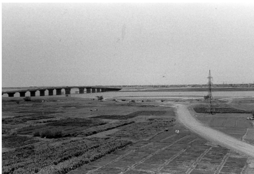
La route d'accès aux terres de Mugran, préalable à la construction de la digue
