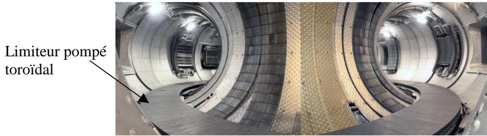
**Figure 2 : Intérieur de la chambre toroïdale de Tore Supra**
