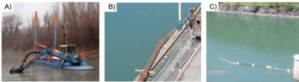
Photographie 4.2 - (A) Petite drague utilisée pour les petites opérations de dragage (entre 1 000 et 2 000 m 3 environ) ; (B) conduite par laquelle le galet aspiré transite à l'aval du barrage et (C) rejet des sédiments à l'aval du barrage (clichés :J.Lejot, 2004)
