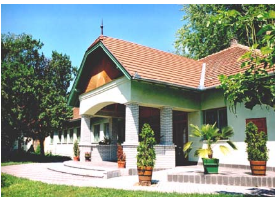
La mairie rénovée de Lakitelek
