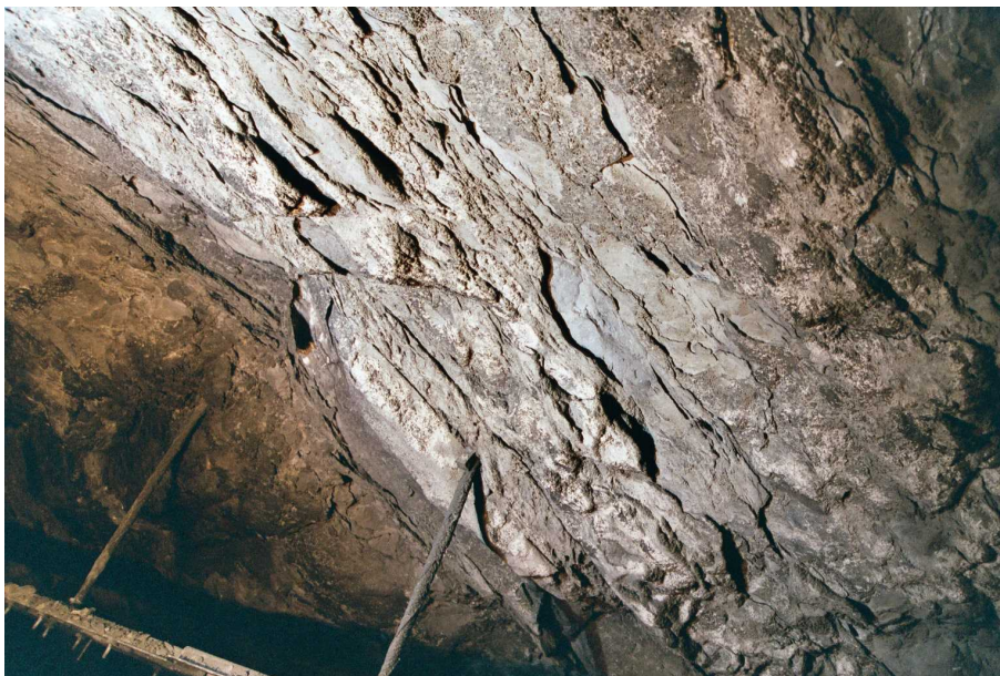
Fig. 1.9 – Parois du tunnel du Chat photographiées pendant l'inspection de 2005 (Cetu).
