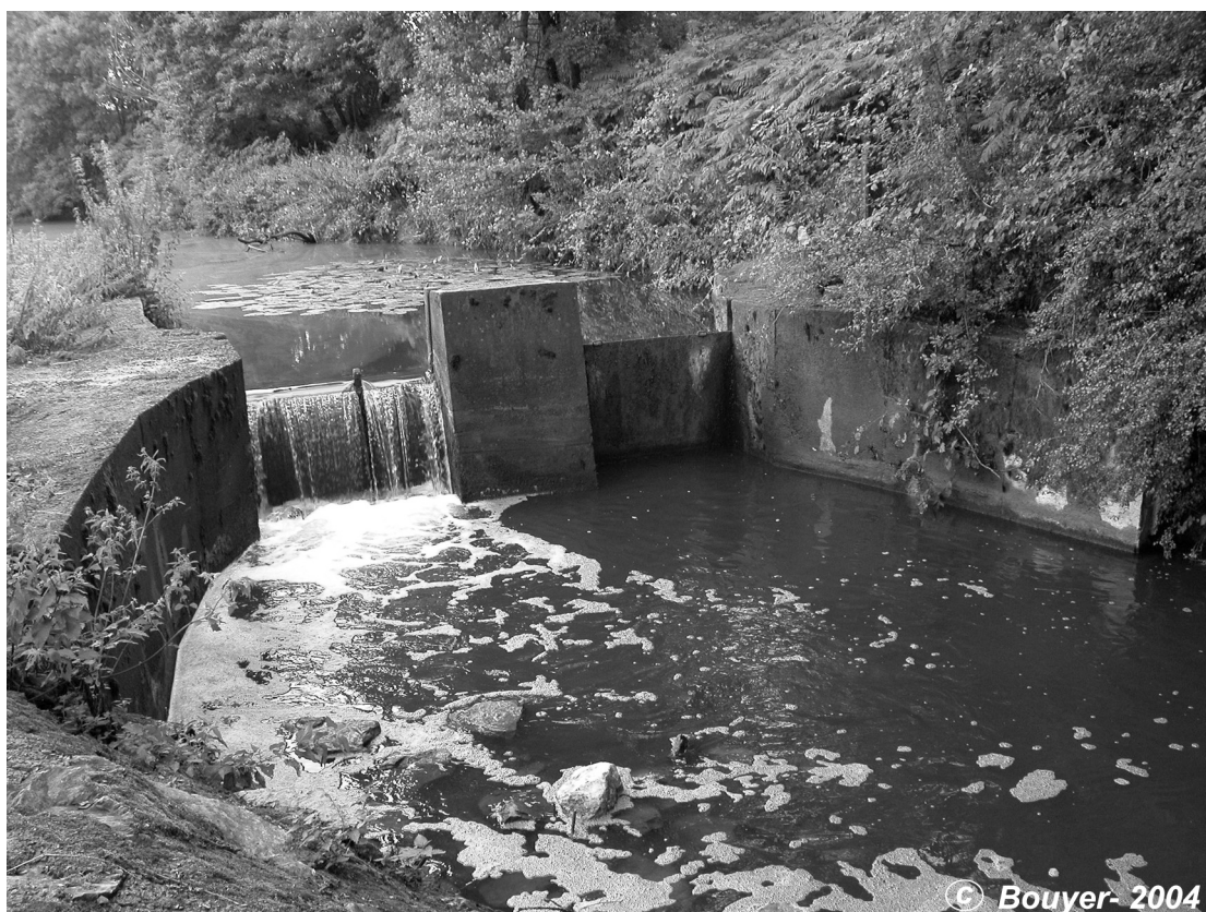
Photo 9 : Exemple d'ouvrage hérité de la fin du XIX e (Evre amont)
