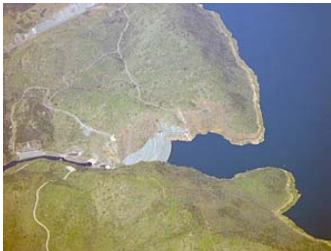
Figure 38: Vue aérienne de New Melones, le dernier des grands barrages. D'une hauteur de 190 mètres, il produit 300,000 KW d'électricité.
