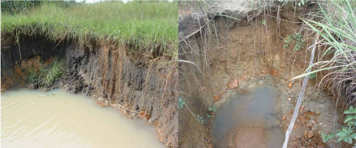
Figure 52 : Écoulement de subsurface sur le bassin d'Ara (long. : 1.6639° E, lat. : 9.7622° N, août 2003).
