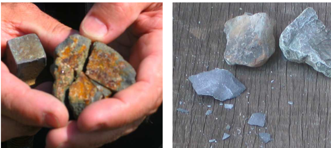
Figure 1.6: Grains de ballast brisés après le passage de la bourreuse. Photos prises lors d'une visite de chantier près de Nîmes.
