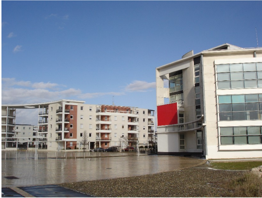
Figure 47 : Le « centre de vie » du quartier, à l'intersection du mail F. De Lesseps et de l'avenue E. Michelin, au premier plan l'esplanade déserte, à droite, l'ancien siège social de « Zebank » aujourd'hui immeuble de bureaux, au centre le mail pavé et au dernier plan, l'ensemble résidentiel « Le Magellan » et son porche monumental.
