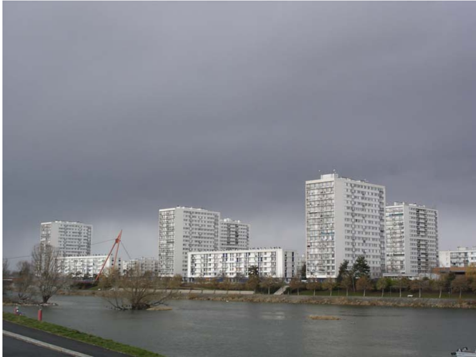
Figure 38 : Le Cher, limite nord du quartier. Au premier plan les quais-promenades aménagés, au second plan le Cher et à gauche en rouge l'armature de la passerelle reliant le quartier des 2 Lions au quartier des Rives du Cher que l'on voit au dernier plan.
