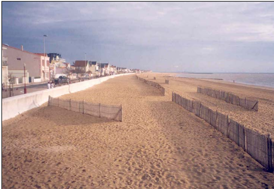
Figure 23 : photographie de la plage de Châtelailon après les opérations de rechargement, 2004.
