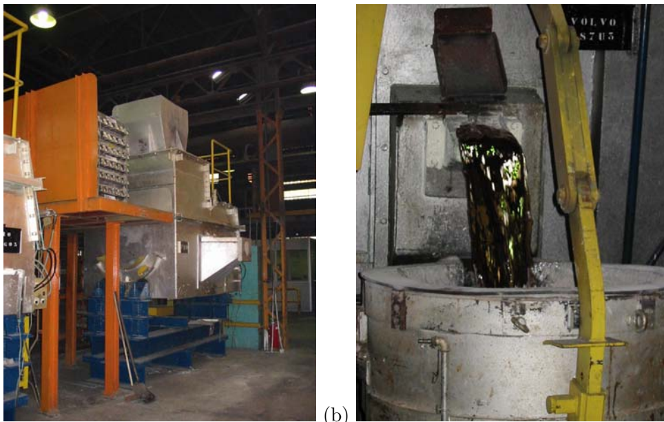
Fig. B.1 – (a) Vue d'un four à gaz pour la fusion des éléments de l'alliage (b) aluminium liquide sortant du four.
