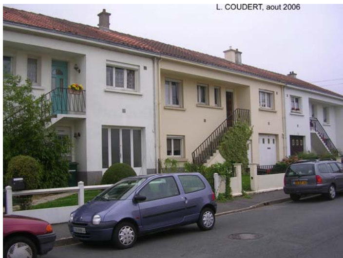
Photographie 6 – Maisons jointives de la fin des années 1950, rue de Toronto, à Saint-Sébastien-sur-Loire, dans la périphérie nantaise.
