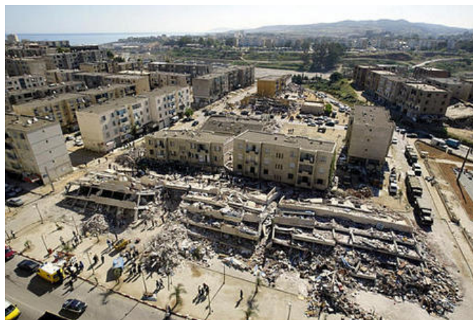
Figure 1.33: Photo prise après le séisme de Boumerdès (21/5/2003) montrant un quartier de Boumerdès totalement dévasté alors que les quartiers limitrophes semblent n'avoir subi que des dégâts mineurs.
