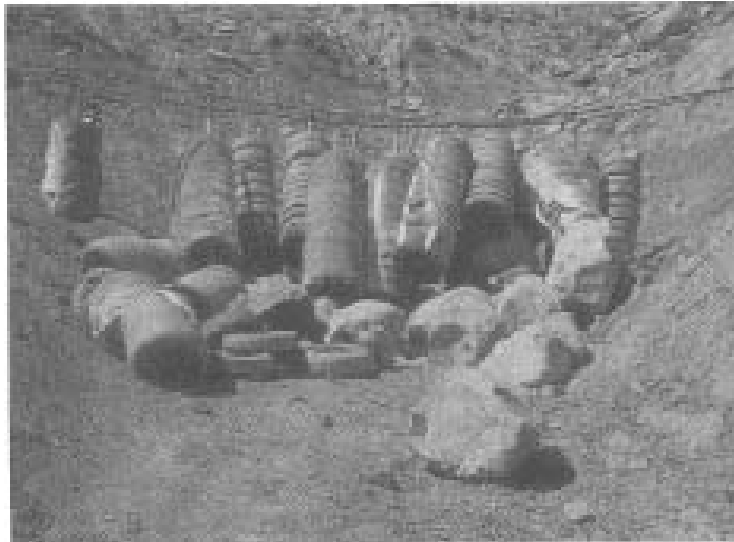
Figure I 7 : Dispositif amortissant composé de piles de pneus accrochées à un câble [CRS 1991]
