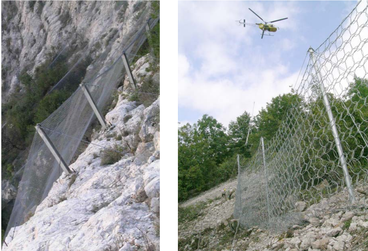
Figure I 6 : Filets pendus, Filets de protection ASM (IMS-RN)
