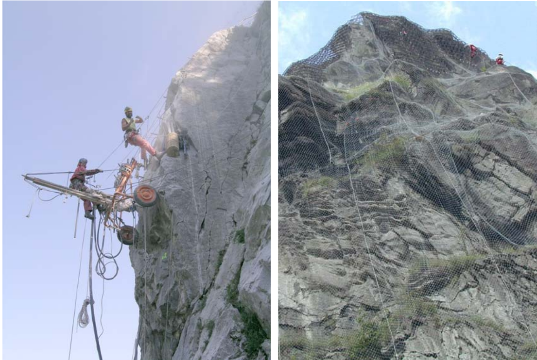
Figure I 4 : Clouage, Filets plaqués (IMS-RN)
