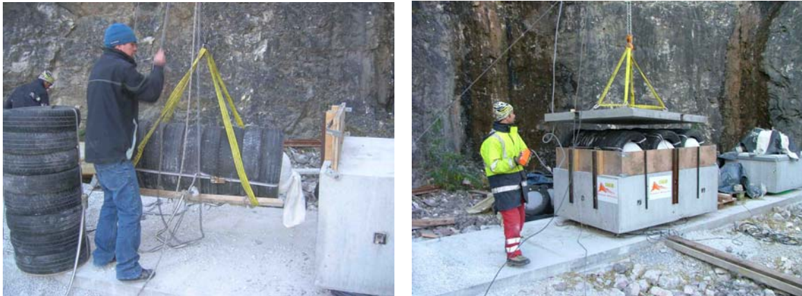
Figure III 3 : Mise en place de la colonne de pneus sur le socle, Mise en place de la dalle en béton armé sur les 3 colonnes de pneus
