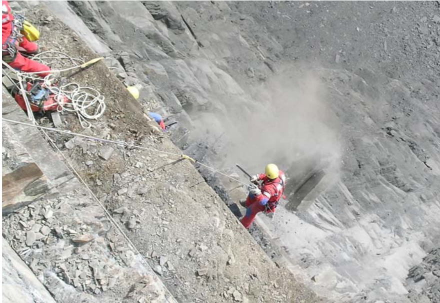
Figure I 3 : Purge au petit train de la Mure (IMS-RN).
