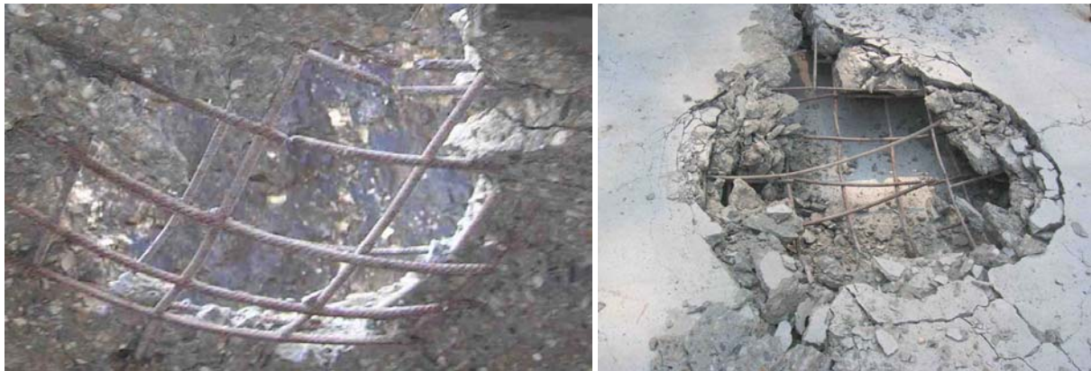
Figure III 27 : Etat du ferrailage après un impact à 45 kJ et 90 kJ
