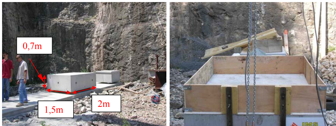
Figure II 14 : Socle support en béton armé, Coffrage en contre plaqué
