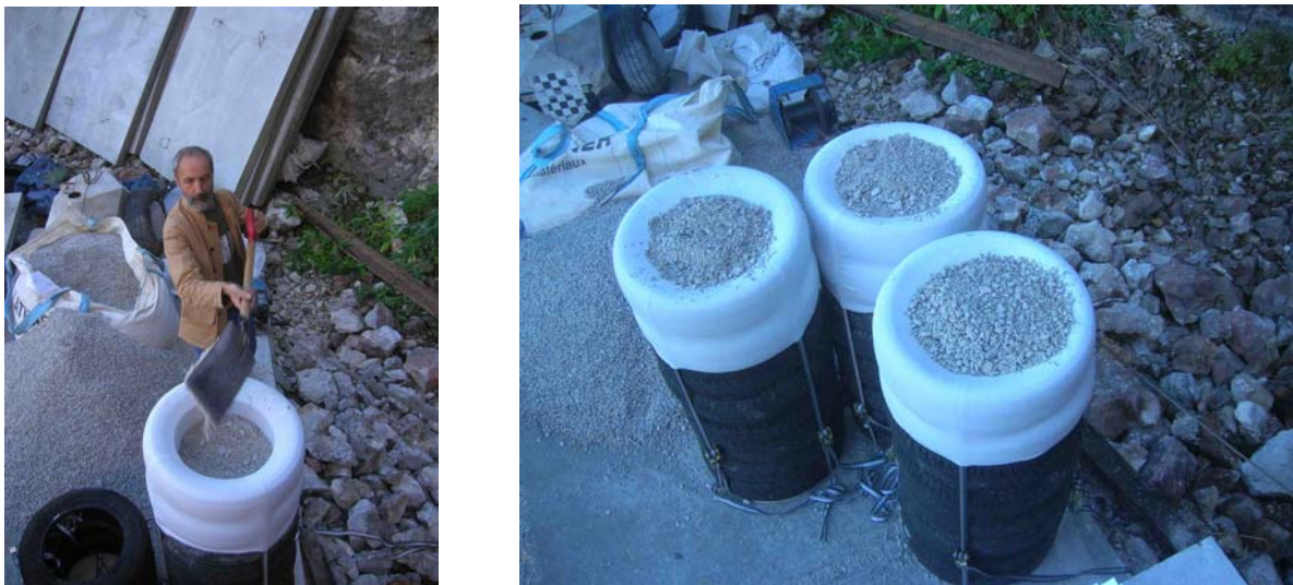
Figure III 2 : Remplissage des chaussettes de géotextile de grave
