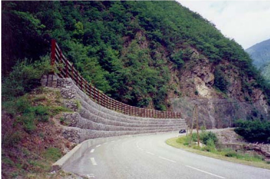
Figure I 12 : Merlon de type gabion (IMS-RN)
