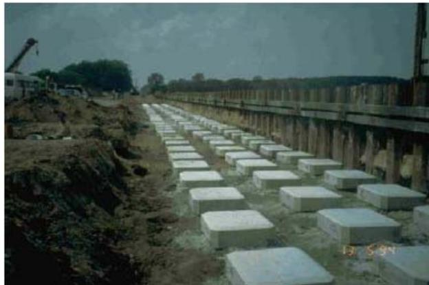
**Figure 4 – Chantier de remblai ferroviaire, visualisation des têtes d'inclusion avant l'édification du remblai, d'après Zanziger et Gartung (2002)**
