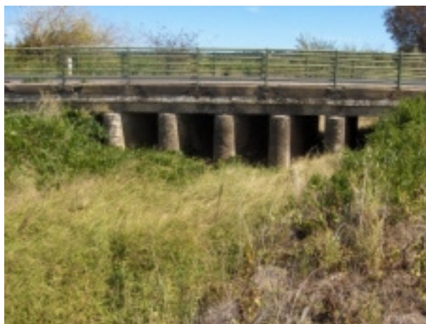
Figure B-I.a : Pont de la station K fin août 2006.
