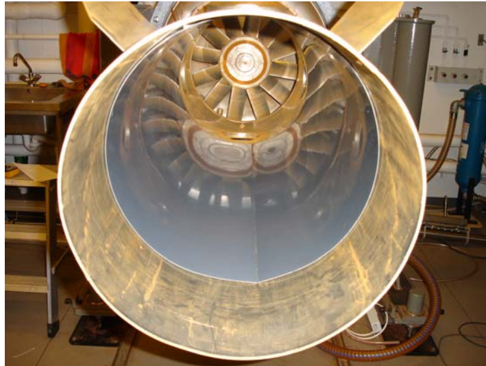
Figure 3.21 Photographie de la feuille isolante couvrant la paroi métallique de la section expérimentale du tunnel.
