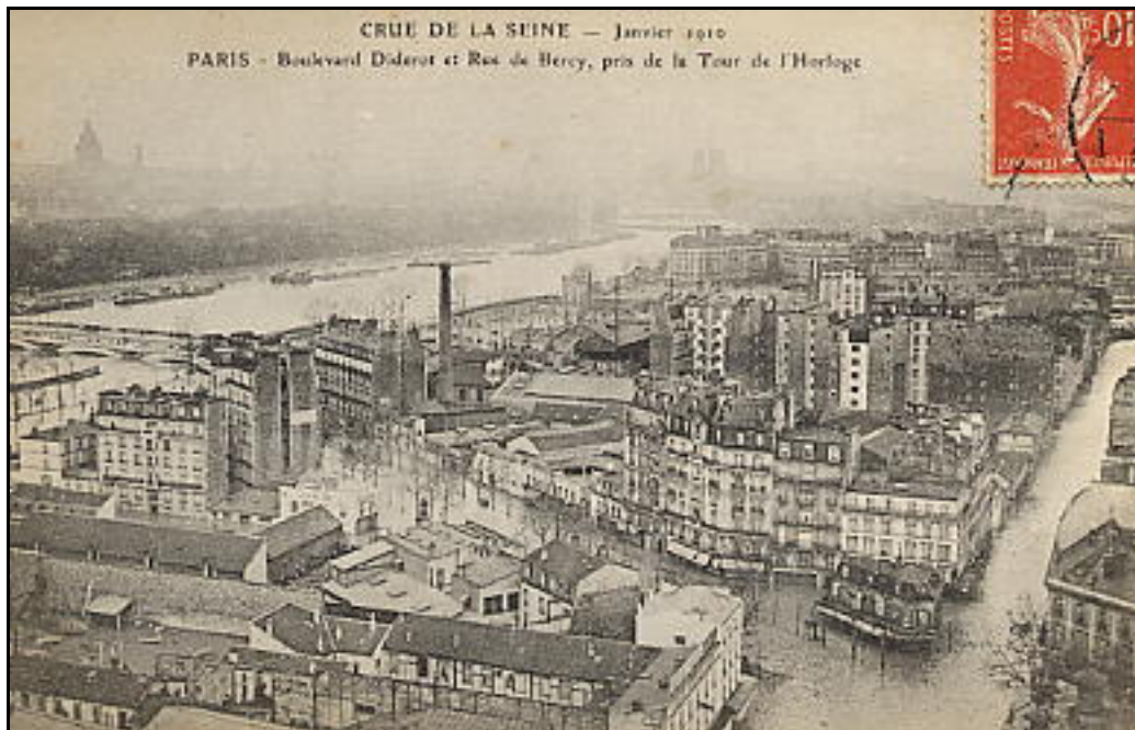
Figure 13 : le carrefour Diderot - Bercy vu depuis la Tour de l'Horloge de la Gare de Lyon lors de la crue de la Seine à Paris en janvier 1910
