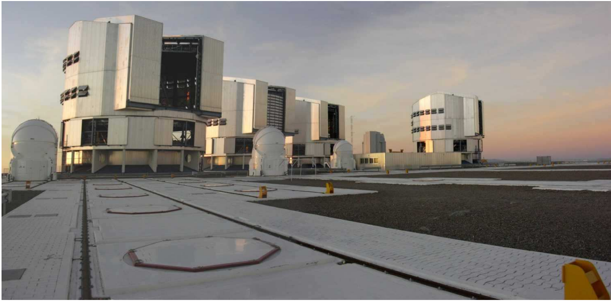
F . 1.3 – J’ai photographié le VLT, avec en arrière plan les quatre UT et VST (dôme tout au fond) et en avant plan les trois AT ainsi que les rails et stations de ces derniers (avril 2006).
