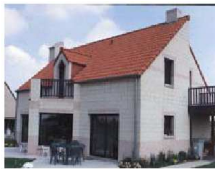
Figure 1.2 – Une application courante des blocs : la construction de murs
