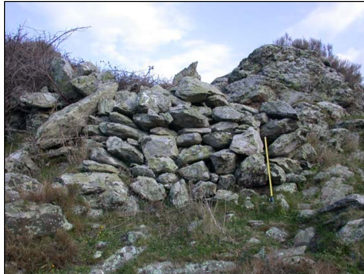
Figure 373 : Tronçon d'enceinte du site de Monte Pietescu (I K 08)
