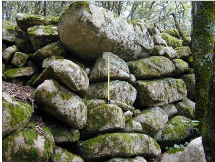
Figure 151 : Tronçon d'enceinte du site de Punta Grimaldella (I D 07)
