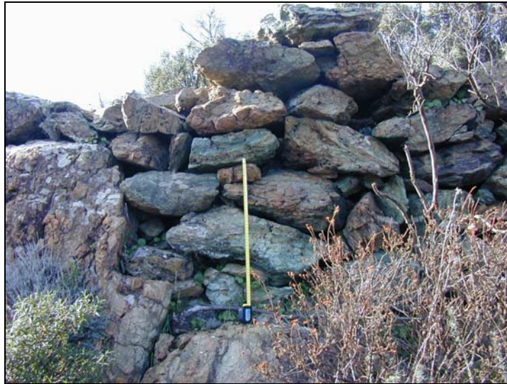
Figure 336 : Tronçon d'enceinte du site de Castellu (I J 10)
