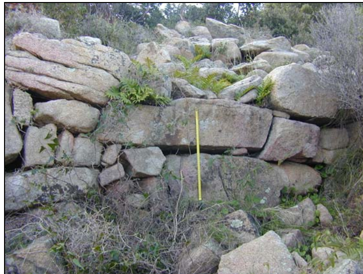
Figure 193 : Tronçon d'enceinte du site de Villa Franca (I F 09)
