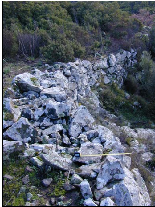
Figure 345 : Tronçon d'enceinte du site de Punta Castellare (I J 13)
