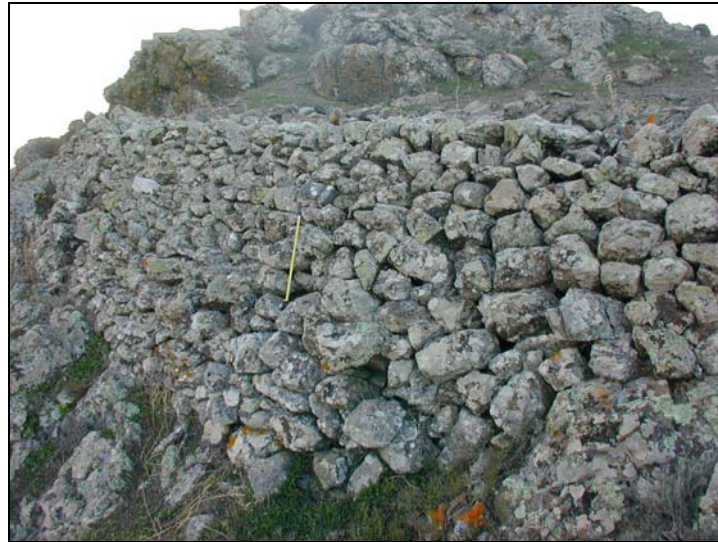
Figure 91 : Tronçon d'enceinte du site de Punta Corbajola (I C 01)
