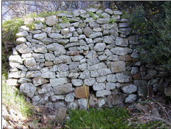
Figure 394 : Tronçon d'enceinte du site de Cerrecchio (III 01)
