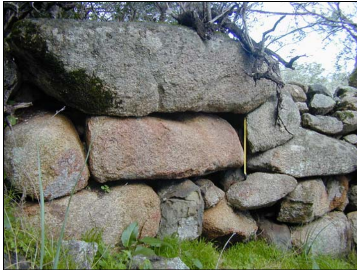
Figure 223 : Tronçon d'enceinte du site de Punta d'Apazzu (I F 19)
