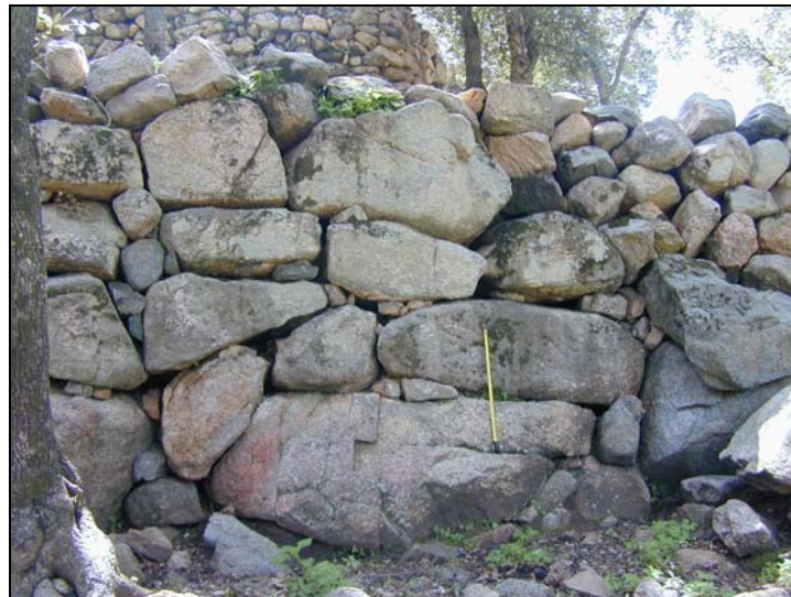
Figure 172 : Tronçon d'enceinte du site de Castellu di Contorba (I F 02)
