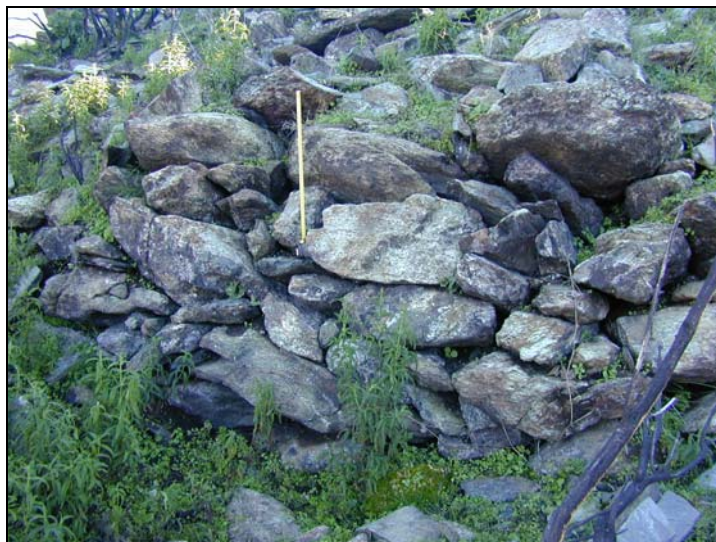
Figure 321 : Tronçon d'enceinte du site de Côte 419 (I J 05)
