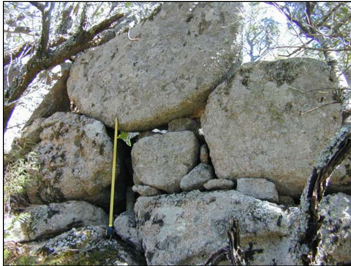
Figure 280 : Tronçon d'enceinte du site de Punta di a Purraja (I H 08)
