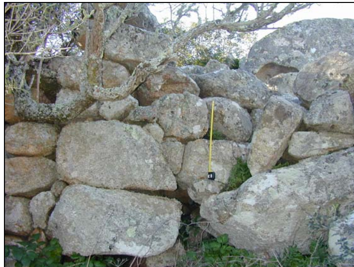
Figure 214 : Tronçon d'enceinte du site de Canava (I F 16)
