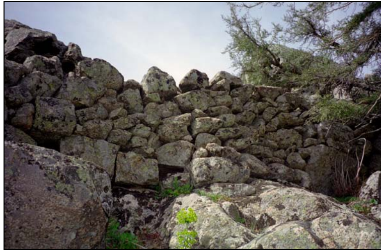
Figure 118 : Tronçon d'enceinte du site de Petre Grosse (I C 10) (Hauteur : 1,30 m)
