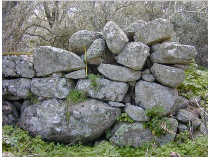
Figure 262 : Tronçon d'enceinte du site de Valle (I H 02)
