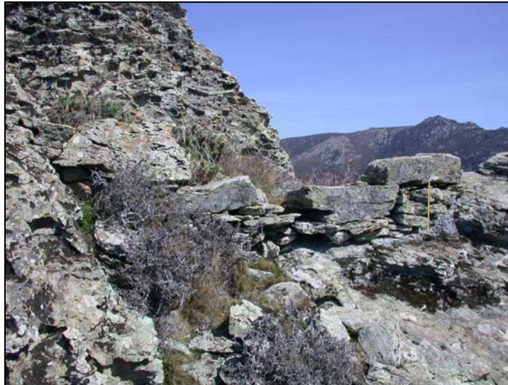
Figure 312 : Tronçon d'enceinte du site de Figa d'Ortu (I J 02)
