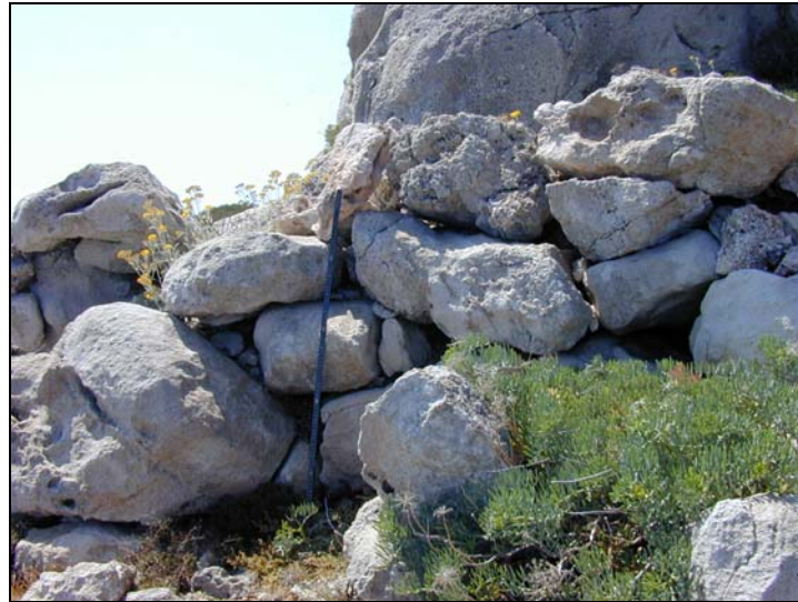
Figure 387 : Tronçon d'enceinte du site de Stronzolo di Orlando (II 02)
