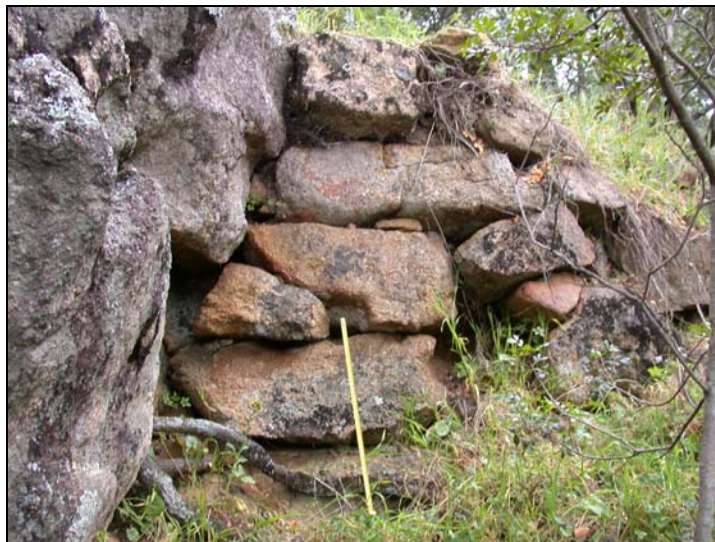
Figure 153 : Tronçon d'enceinte du site de Castiglione - Terra Bella (I D 08)
