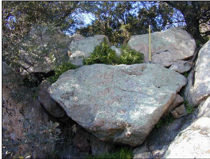
Figure 232 : Tronçon d'enceinte du site de Punta di a Villa (I F 22)
