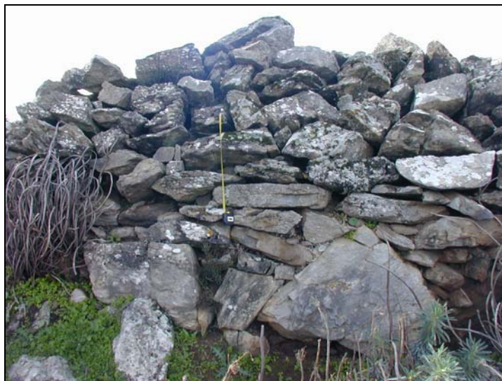
Figure 339 : Tronçon d'enceinte du site de A Fuata (I J 11)
