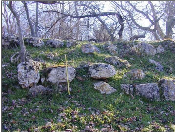
Figure 400 : Tronçon d'enceinte du site de Poggio Bagno Santo (III 03)
