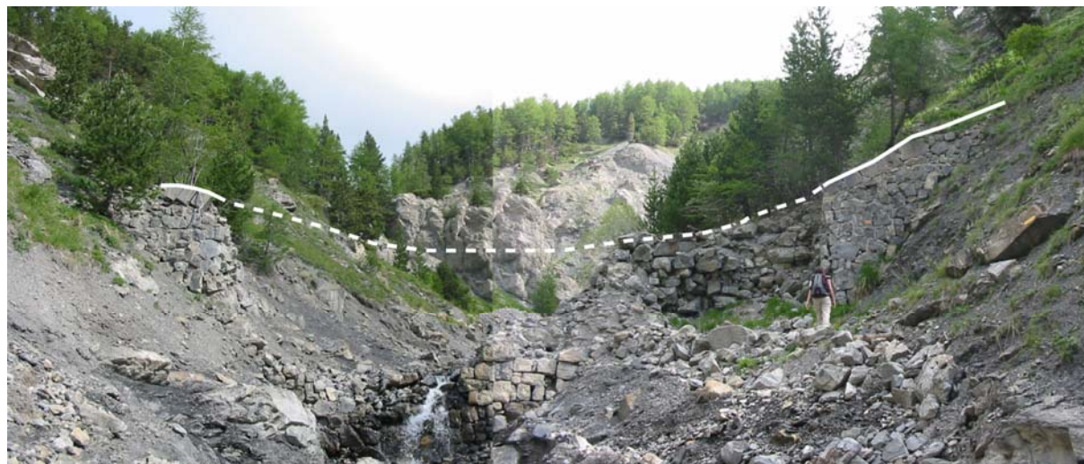
Figure 6.4 : Vue sur les vestiges du seuil 54, le niveau sommital du seuil est représenté en pointillé blanc.
