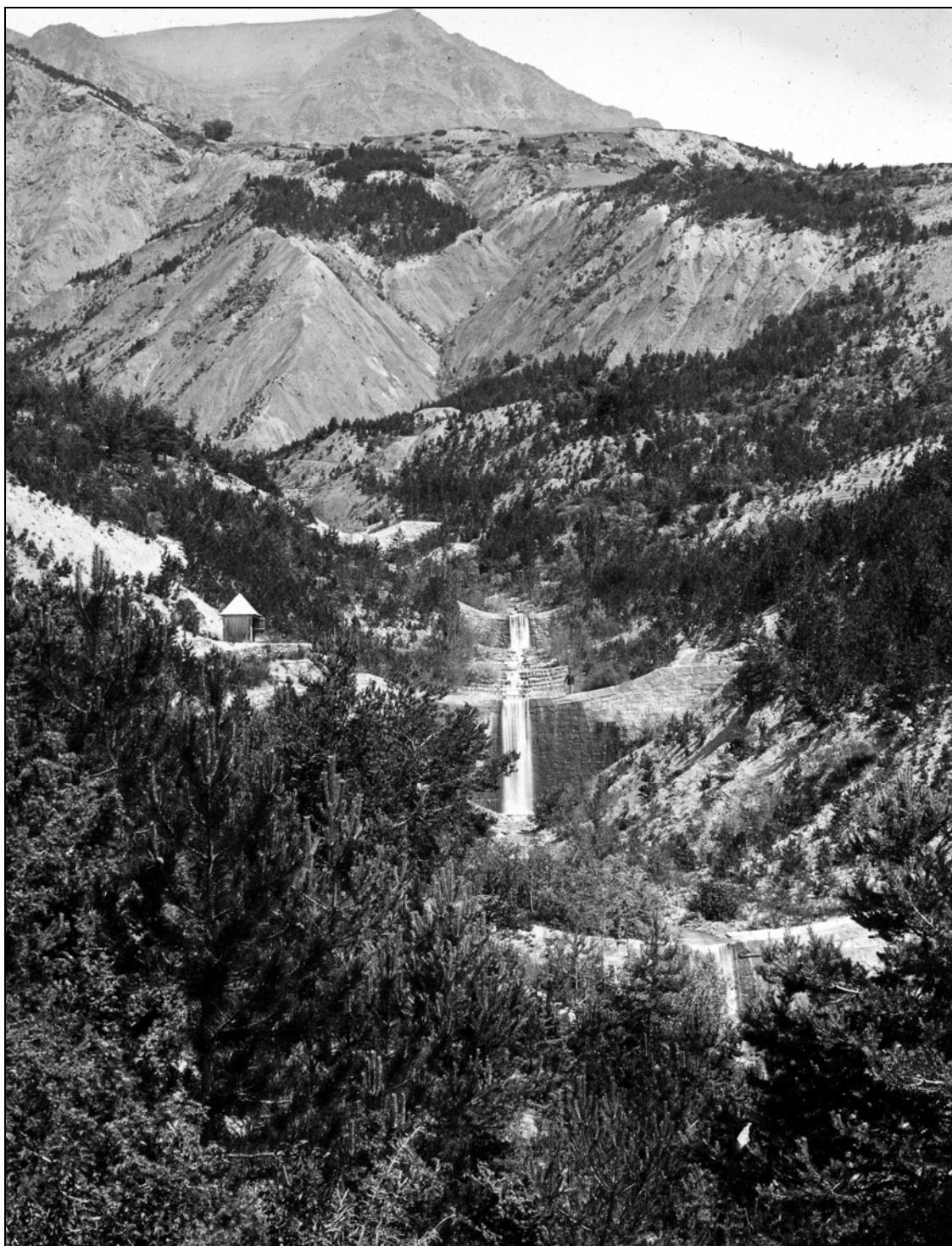
Figure 3.16 : Vue en 1885 sur les barrages torrentiels en partie basse du torrent du Bourget.
