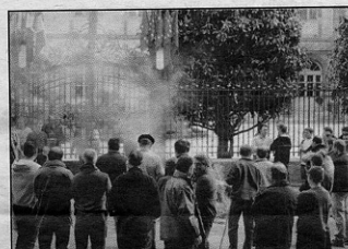
Préfet, a porté plainte contre X, auprès des services de Police qui ont transmis au Procureur de la République, "pour outrage au dra-
