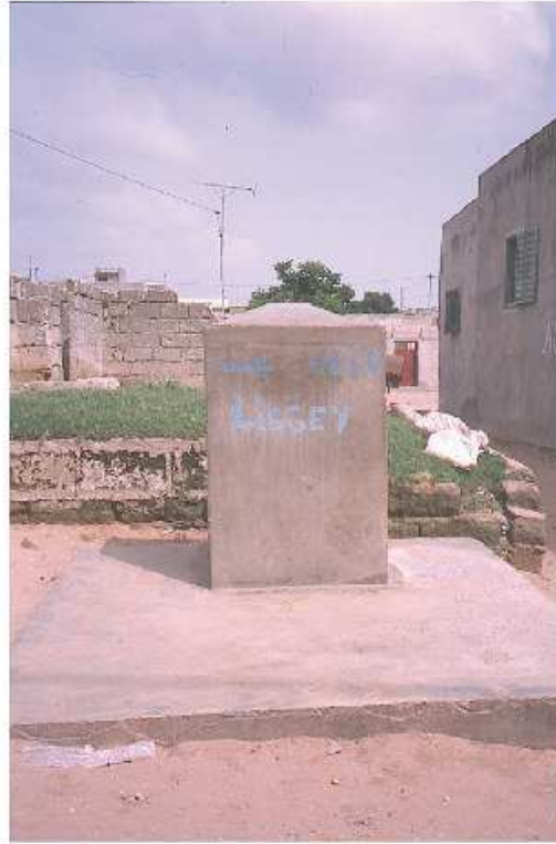
Photo 14 - La borne-fontaine du quartier Afia (juillet 2001)
