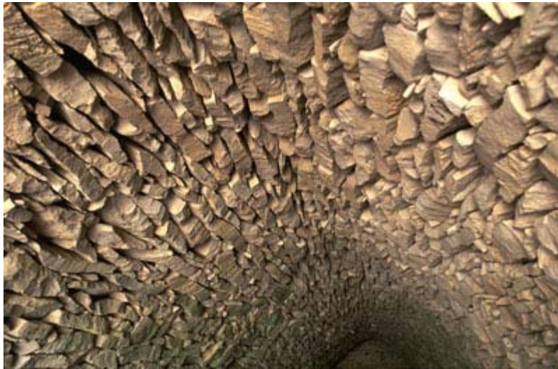
Figure 2 : Voûte d'une construction en pierre sèche (aucun mortier ne fixe les pierres entre elles) – photo tirée du site http://www.pierreseche.com de Christian Lassurance.
