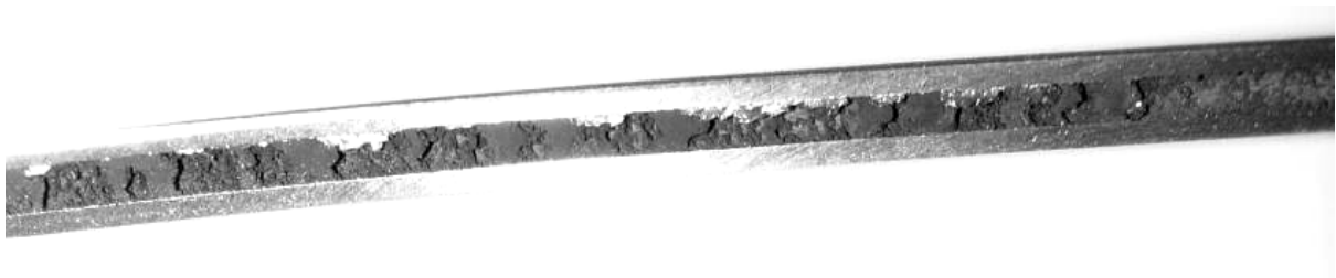
Figure 81. Tube de diamètre interne 1,8 mm bouché par un dépôt carboné friable sec.
