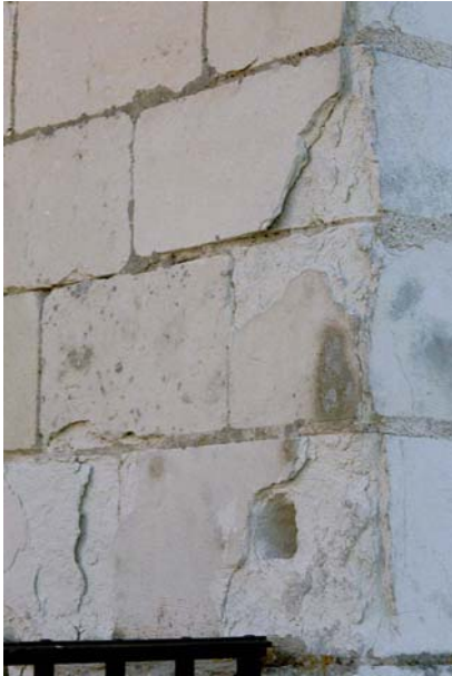
Figure I.13 : altération en plaques initiée sur des pierres d'angle (château de Chaumont)
