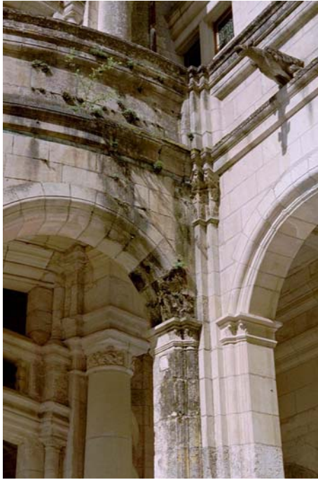
Figure 1.25 (ci-dessus) : développement de mousses et de lichens à la base d'un mur en tuffeau (château de Chambord)
