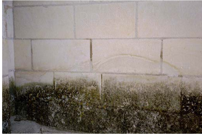
Figure 1.25 (ci-dessus) : développement de mousses et de lichens à la base d'un mur en tuffeau (château de Chambord)
