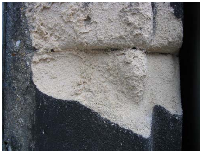
Figure I.19 (ci-dessus): désagrégation sableuse sur un mur en pierre de Sébastopol (Mello)
