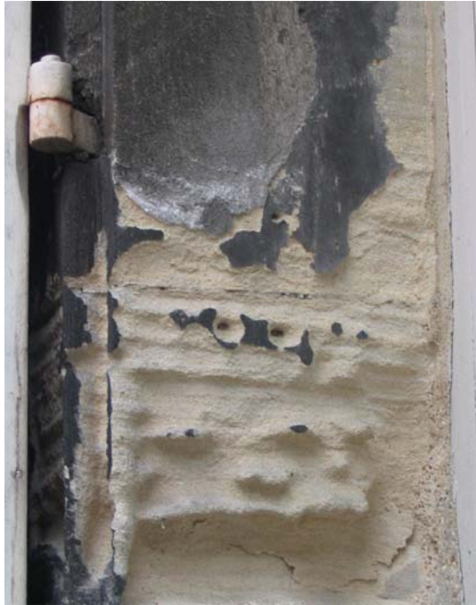
Figure I.21 (ci-dessus) : alvéolisation sur un mur en tuffeau (château des ducs de Bretagne – Nantes)
