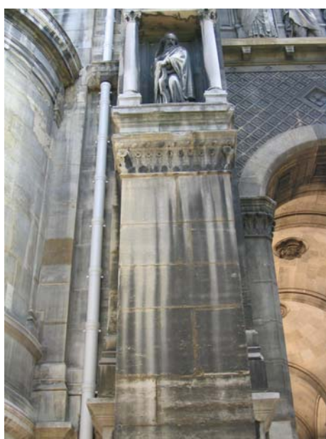
Figure I.7 : dépôt de suies noires limité par le ruissellement des pluies sur un mur en pierre de Sébastopol (église St-Augustin – Paris)
