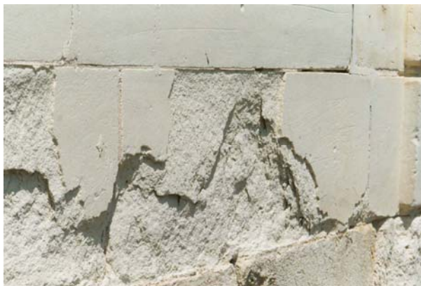
Figure I.11 (ci-dessus) : altération en plaques (de plusieurs centimètres d'épaisseur) sur un mur en tuffeau (château de Valencay)
