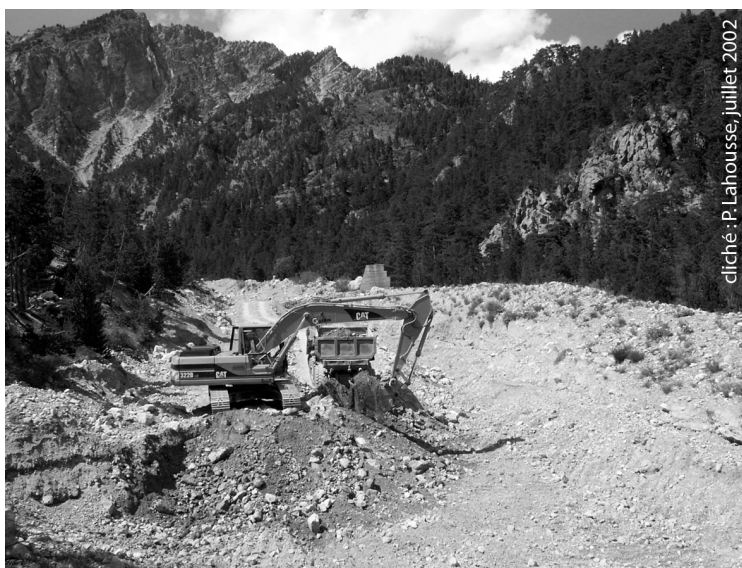
Photo. 36 : le curage du lit du torrent de Malefosse
