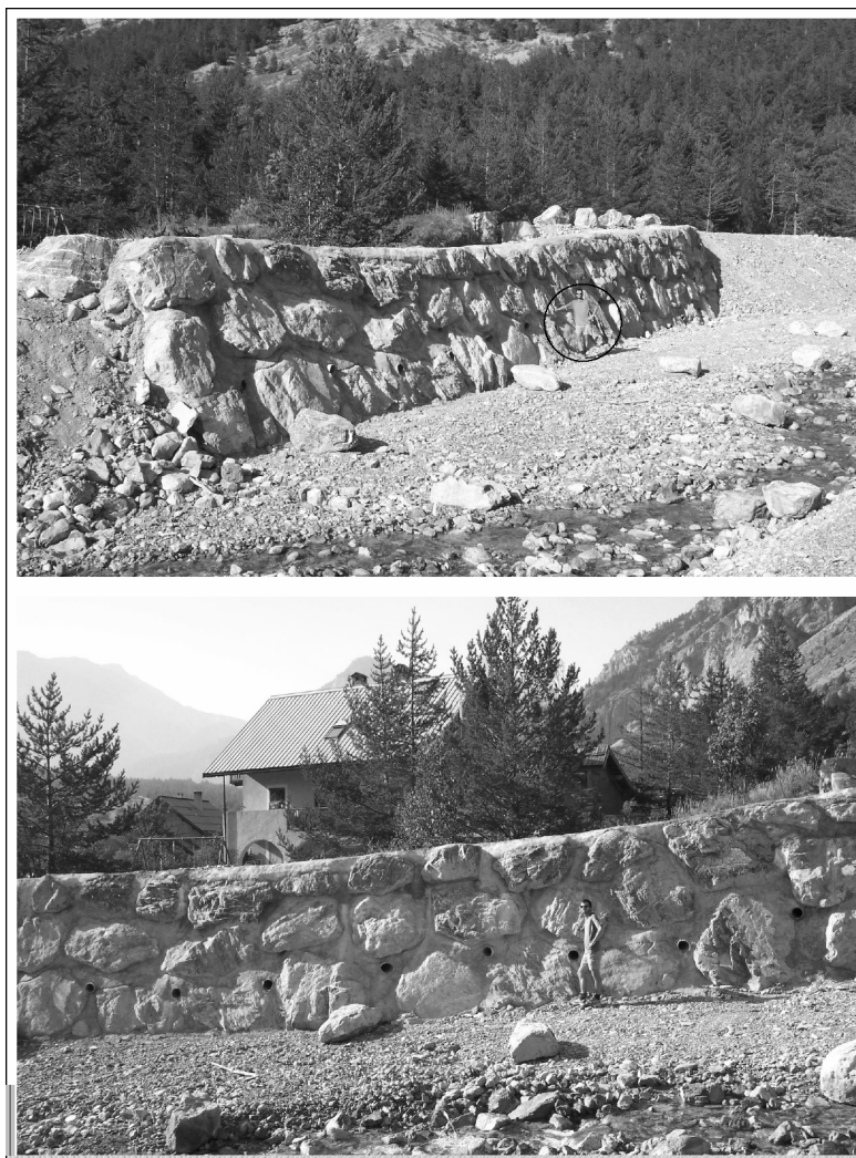
Photo. 37 : la digue de protection érigée en 2004 en rive droite du torrent des Acles (photographies, juillet 2005)
