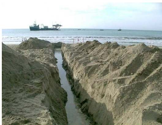
FIG. 2.14 – Photo prise lors de l'installation du câble électro-optique, sur la plage des sablettes, à La Seyne-sur-mer (oct 2001).
