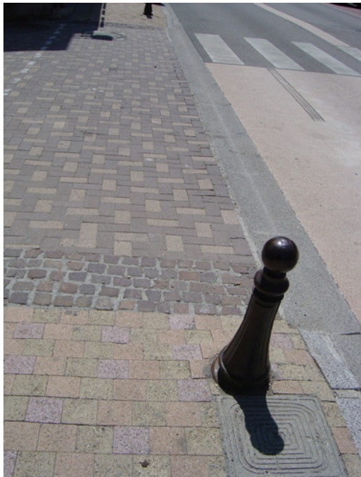
Photographie 74 : La Mure : mélange des styles, patchwork d'enrobés routiers colorés, de pavages géométriques en autobloquants aux coloris variés, de mosaïques en pierre et borne « tradition ».
