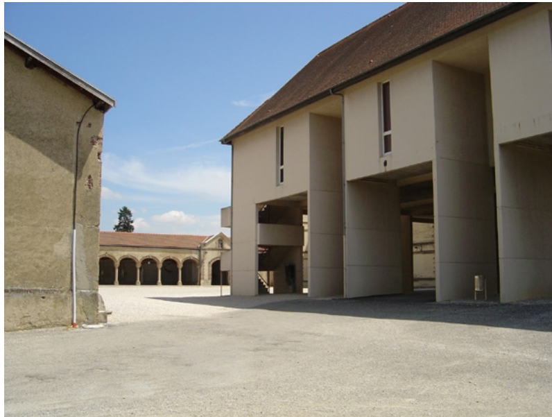
Photographie 47 : La Côte Saint-André, la salle des fêtes construite dans la continuité du château Louis XI : une difficile cohabitation jugée comme une erreur regrettable par le maire [« je trouve aberrant qu'on ait laissé construire une salle des fêtes à côté du château, où on a défiguré... » (Entretien avec Joseph Manchon, op. cit. )].
