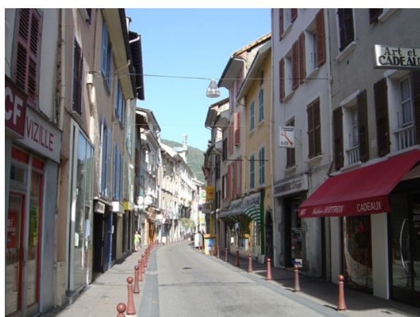
Photographie 68 : Vizille, la rue du Général de Gaulle, semi-piétonne.
