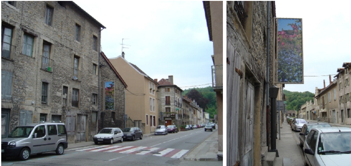
Photographies 31 et 32 : Crémieu, faubourg des Moulins, flammes et décors architecturaux temporaires installés pour requalifier les entrées de ville dégradées et où la requalification lourde s'avère impossible.
