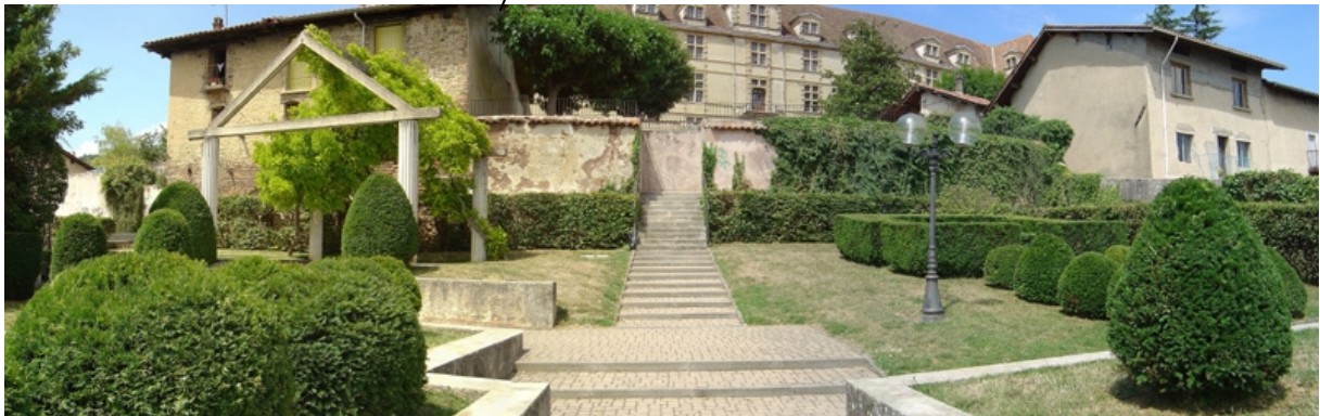
Photographie 38 : La Côte Saint-André, les Terrasses du Douaire, création de cheminements piétons, espaces verts, placettes, terrasses, bassins, éclairage...
