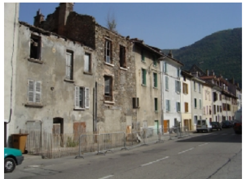
Photographie 65 : Vizille, habitat dégradé rue Jean Jaurès.
