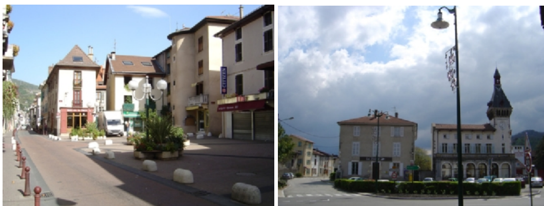
Photographies 105 et 106 : Eclairages à Vizille, Tullins.
