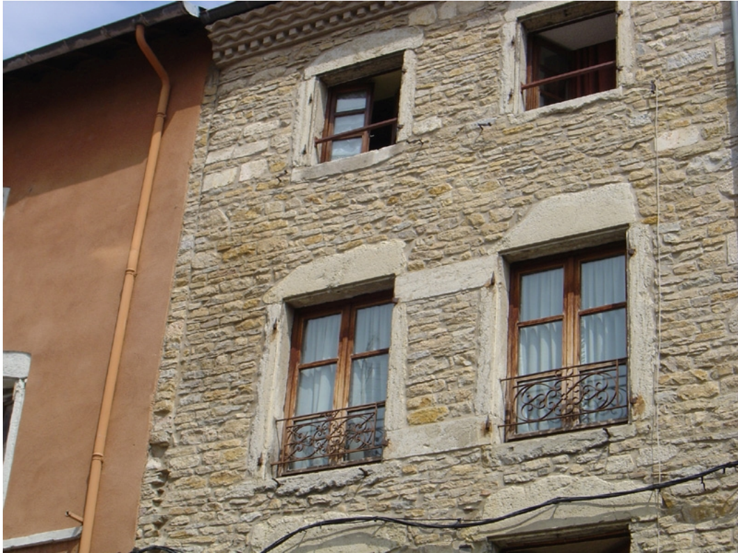
Photographie 122 : Façades à Crémieu, rue Lieutenant Colonel Bel. A gauche façade enduite, à droite les pierres ont été laissées apparentes alors qu'elles n'ont pas vocation à le rester : les pierres d'encadrement des ouvertures, irrégulièrement taillées, l'attestent.
