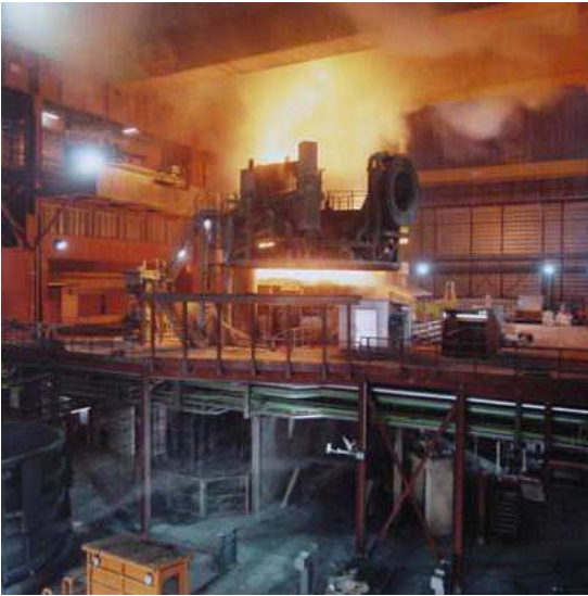
FIG. 1.3 – L'intérieur de l'aciérie de Belval
