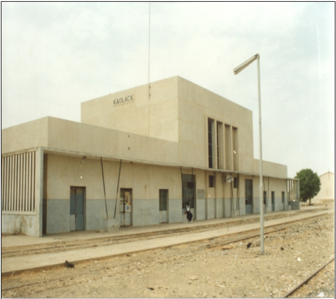
Figure 4 : La gare ferroviaire de Kaolack
