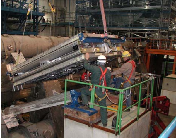
FIG. 2.28 – Insertion d'une chambre à muons de type BMF (Barrel Middle radius Feet) de la partie tonneau entre les aimants toroïdaux.
