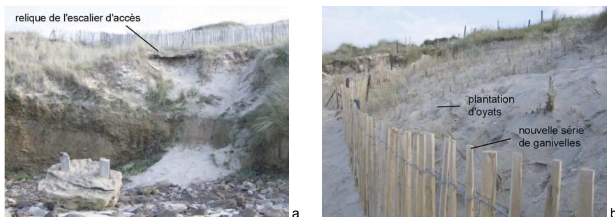
Illustration 162. (a) Démantèlement récent de l'un des escaliers centraux d'accès à la plage et (b) mesures actuelles de réhabilitation de la végétation dunaire aux Blancs Sablons.
